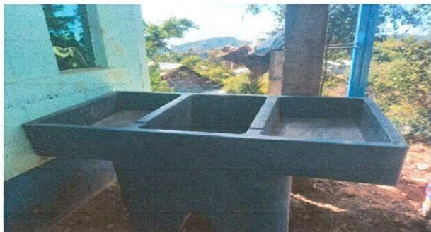
Foto7: Sustitución de pila, por pila plástica
