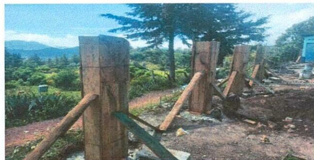
Foto 6: Reparación de muro perimetral
