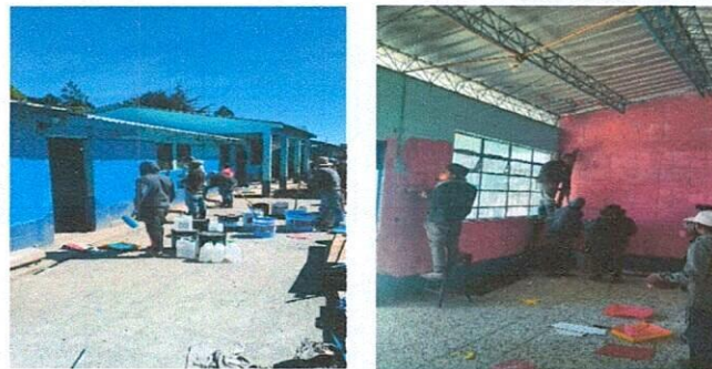
Foto 8: Pintura en muros exteriores e interiores
