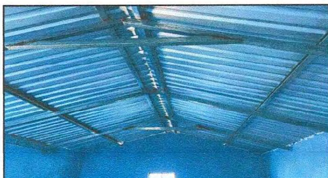
Foto 3: ESTRUCTURA DE TECHO
