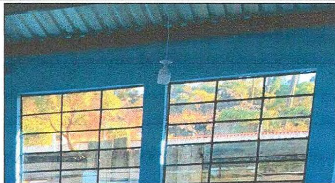
Foto 14: REPARACIÓN DEL SISTEMA ELECTRICO
