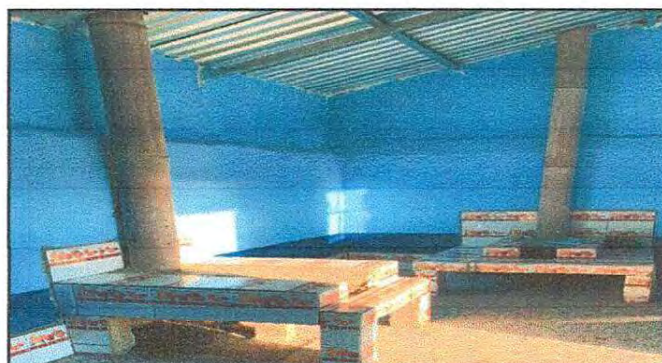
Foto 16: REPARACION DE COCINA (SUSTITUCIÓN DE CHIMENEA DE METAL)
