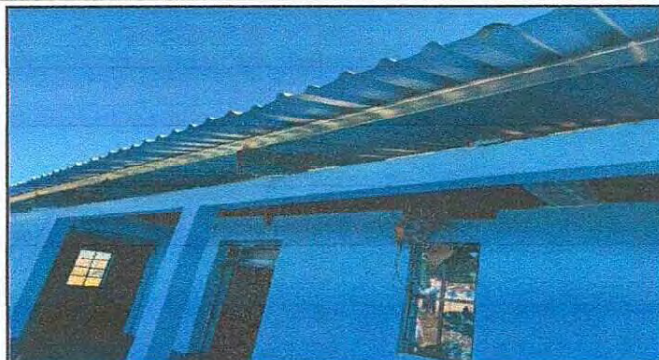
Foto 2: CUBIERTA DE LÁMINA
