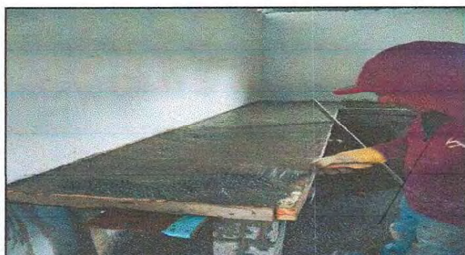
Foto 15: REPARACIÓN DE COCINA (MEJORAMIENTO DE MESA DE CONCRETO)
