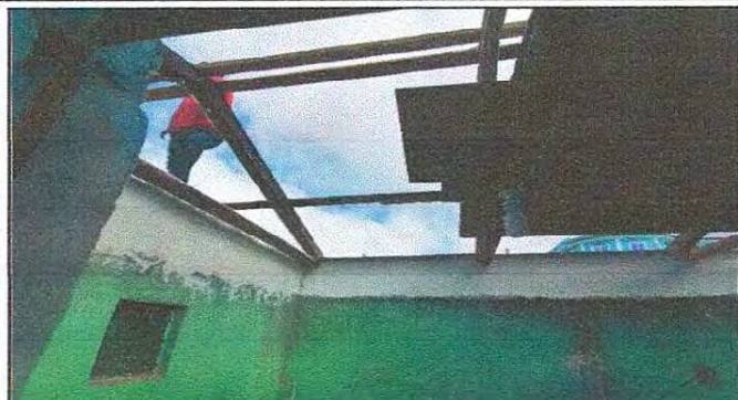
Foto 1: CUBIERTA DE LÁMINA
