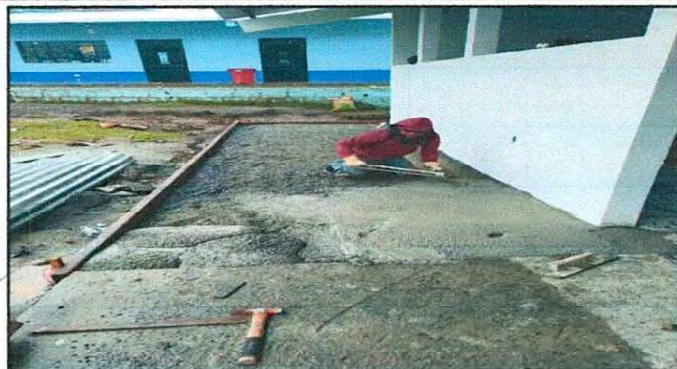
Foto 8: BANQUETA DE CONCRETO (MEJORAMIENTO DE BANQUETA DE CONCRETO)
