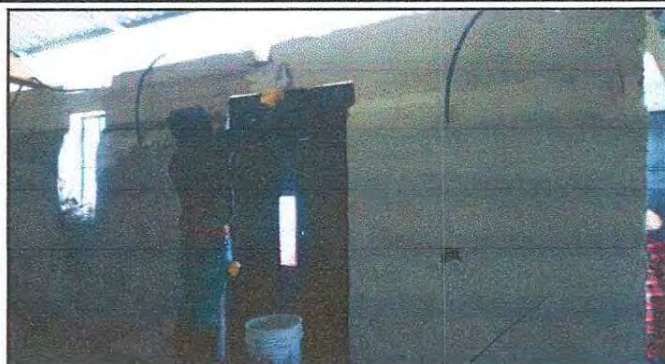
Foto 13: REPARACIÓN DEL SISTEMA ELÉCTRICO
