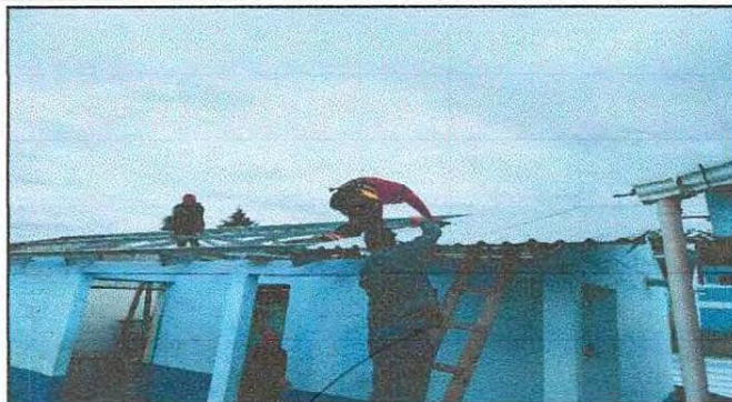
Foto 2: CUBIERTA DE LÁMINA
