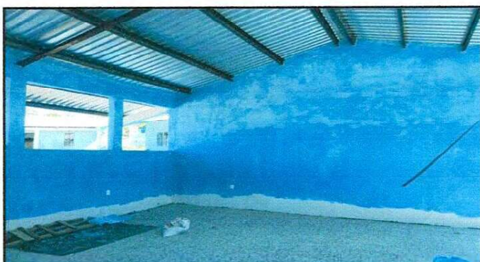
Foto 9: PINTURA EN MUROS INTERIORES
