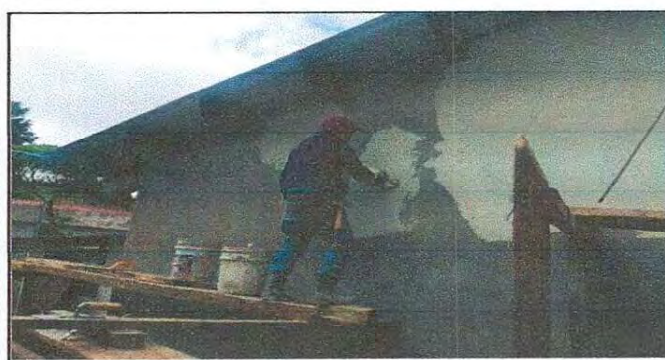
Foto 17: REPARACIÓN DE REPELO Y CERNIDO DE PAREDES
