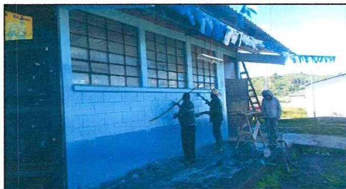
Foto 10: PINTURA EN MUROS EXTERIORES
