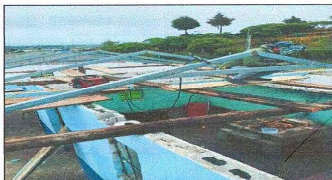
Foto 3: ESTRUCTURA DE TECHO
