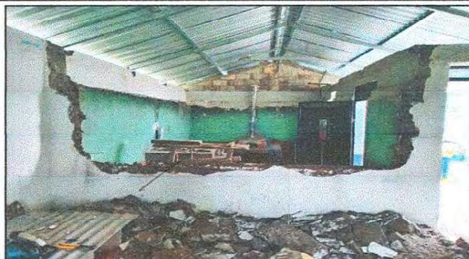
Foto 14: REPARACIÓN DE COCINA
