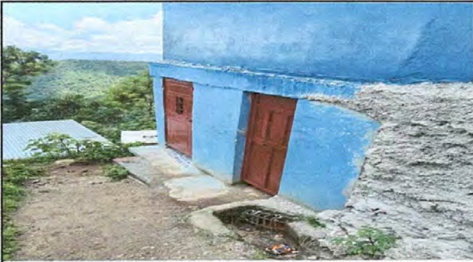
Foto7: Mantenimiento a puertas de baños
