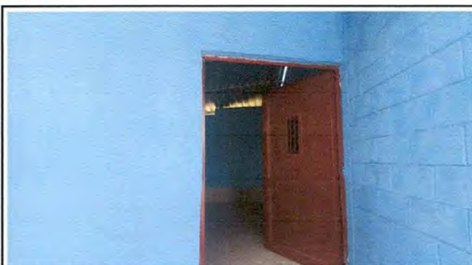
Foto 4: Sustitución de puertas de metal
