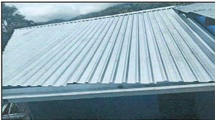
Foto1: Sustitucion de lamina por lamina troquelada calibre 26
