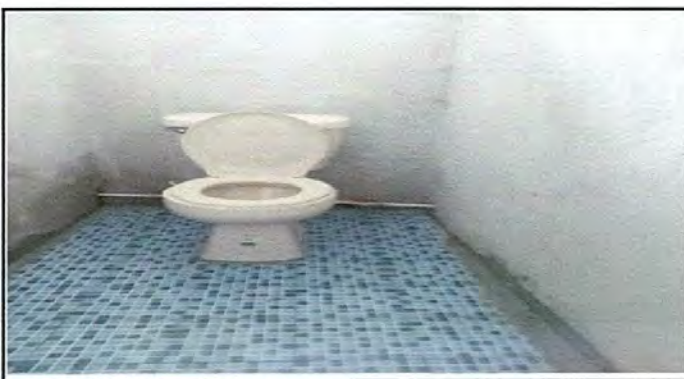
Foto 6: Sustitucion de Sanitarios
