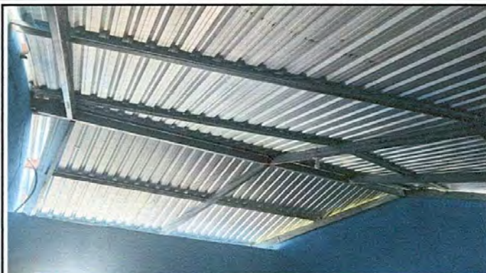
Foto 2: Sustitución de Estructura de madera por metal
