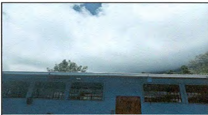
Foto 5: Instalación de Canal calibre 26
