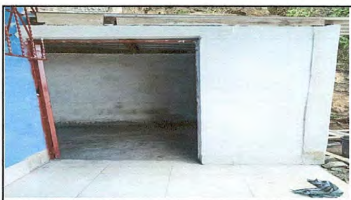
Foto 15: Arreglo de la Bodega
