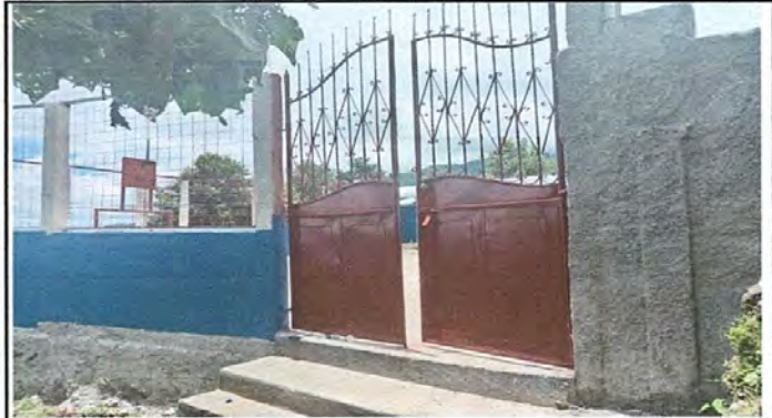
Foto 8: Mantenimiento a porton
