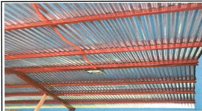
Foto 11: Reparacion del sistema electrico
