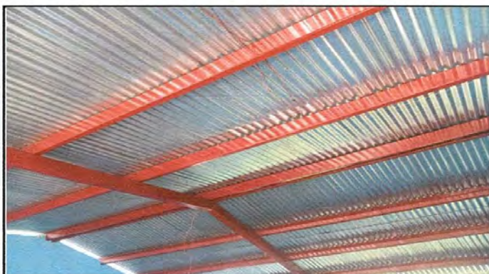
Foto 3: Mantenimeinto a estructura de metal
