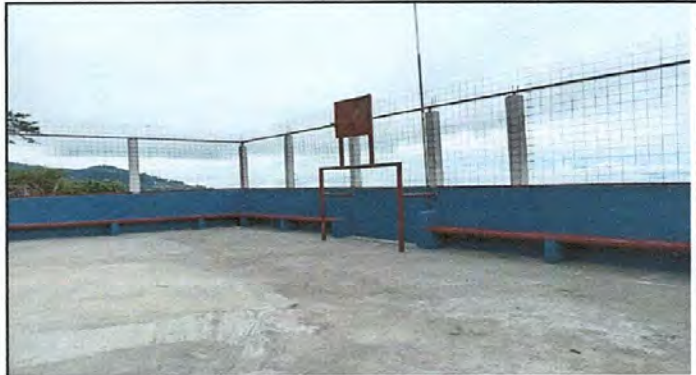
Foto 10: Reparacion de muros perimetrales
