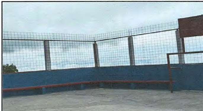
Foto 14: Repello en paredes y muro perimetral
