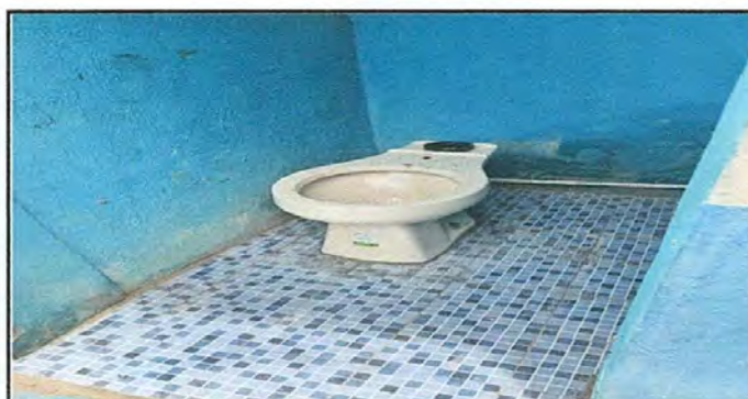
Foto 6: Sustitucion de Sanitarios
