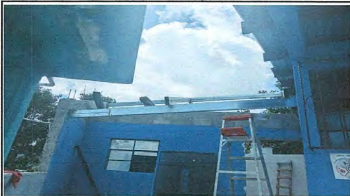
Foto1: Sustitucion de lamina por lamina troquelada calibre 26
