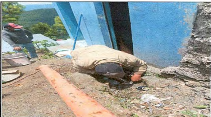
Foto7: Mantenimiento a puertas de baños
