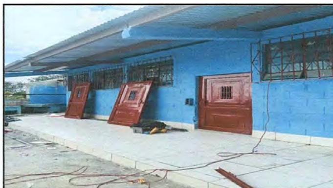
Foto 4: Sustitución de puertas de metal
