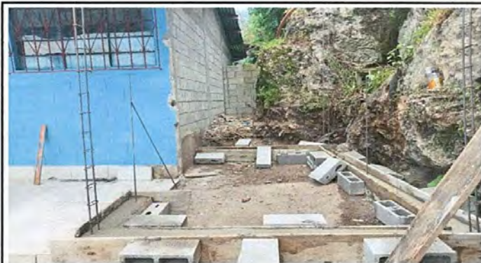
Foto 15: Arreglo de la Bodega
