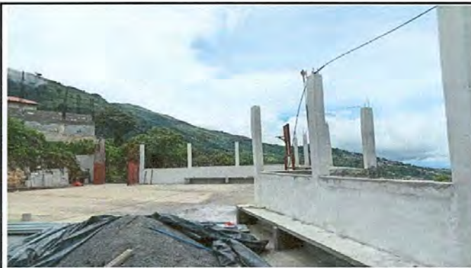
Foto 14: Repello en paredes y muro perimetral
