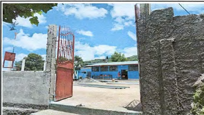
Foto 8: Mantenimiento a porton
