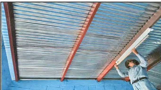
Foto 3: Mantenimeinto a estructura de metal
