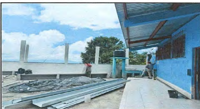
Foto 5: Instalación de Canal calibre 26
