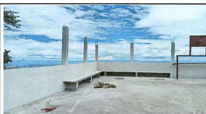
Foto 10: Reparacion de muros perimetrales
