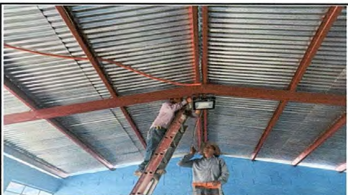
Foto 11: Reparacion del sistema electrico
