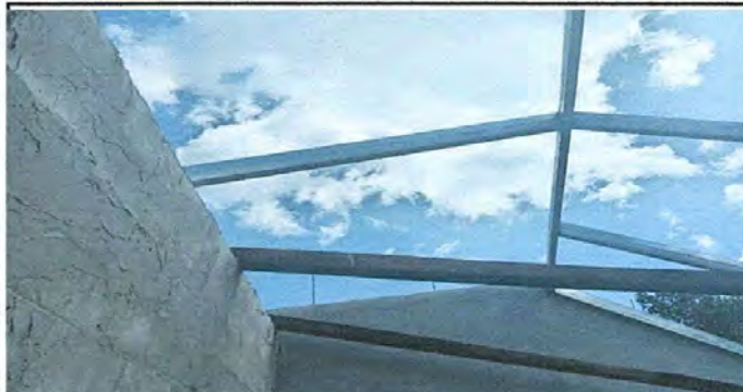
Foto 2: Sustitución de Estructura de madera por metal
