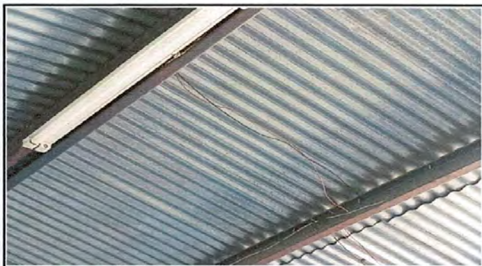
Foto 11: Reparación del sistema eléctrico
