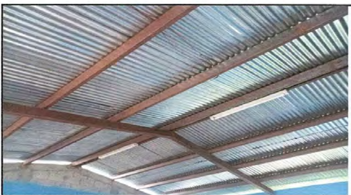
Foto 3: Mantenimeinto a estructura de metal
