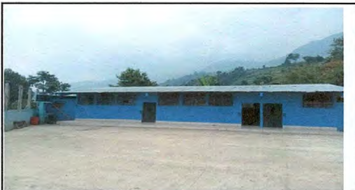
Foto 5: Instalación de Canal calibre 26
