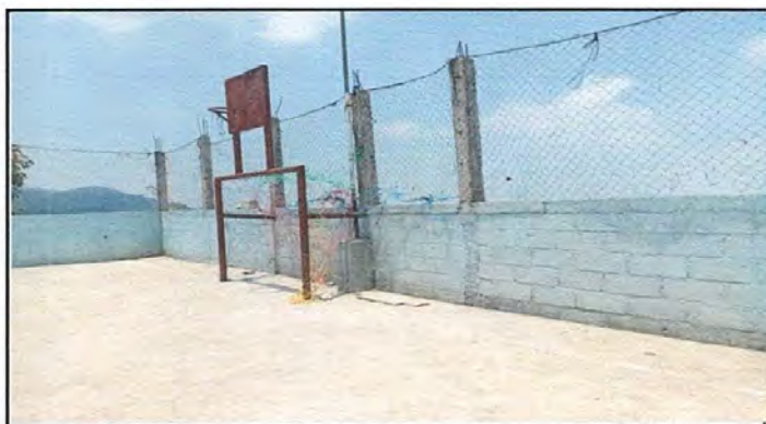
Foto 10: Reparación de muros perimetrales
