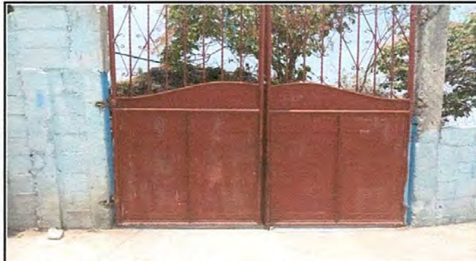
Foto 8: Mantenimiento a porton
