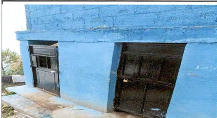
Foto 7: Mantenimiento a puertas de baños
