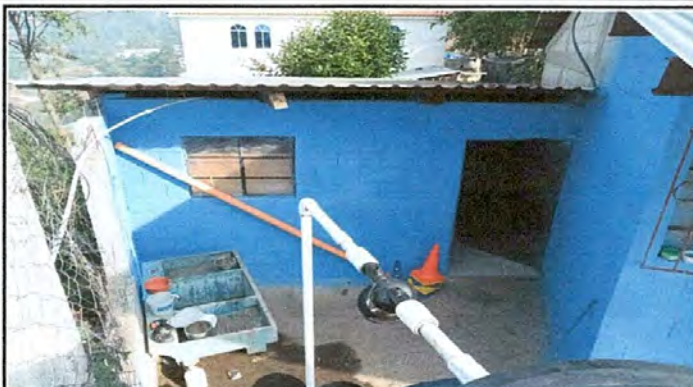
Foto1: Sustitucion de lamina por lamina troquelada calibre 26
