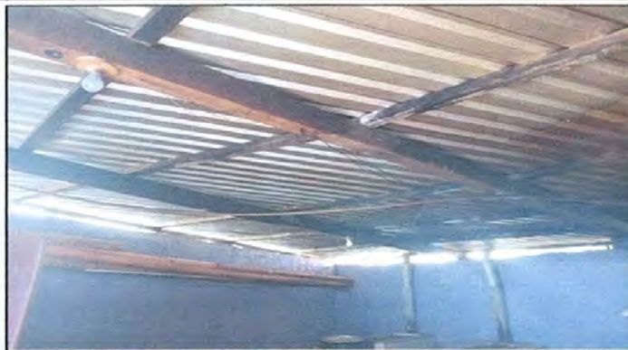
Foto 2: Sustitución de Estructura de madera por metal
