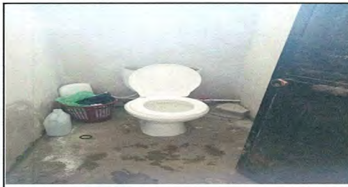
Foto 6: Sustitucion de Sanitarios
