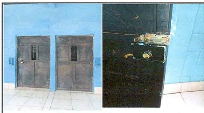
Foto 4: Sustitución de puertas de metal
