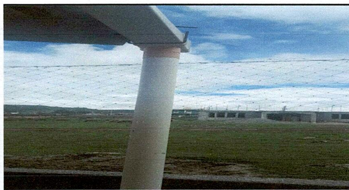
Foto 6: Canales y Bajadas de Agua Pluvial
