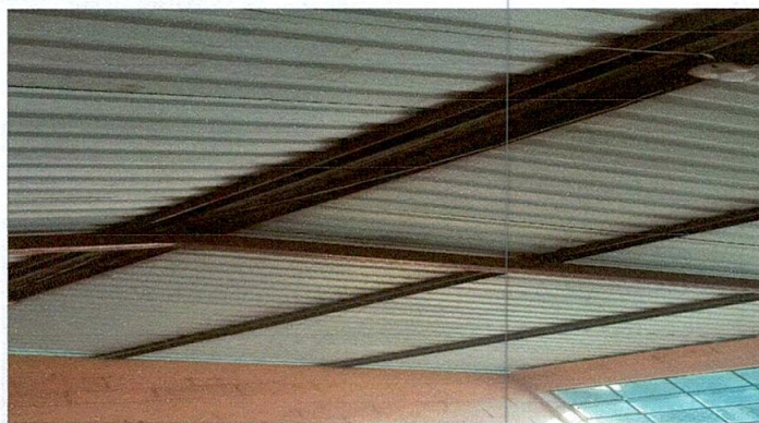
Foto 3: Sustrución de estructura de soporte de madera por estructura de soporte de metal
