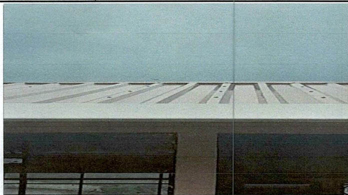
Foto1: Sustrución de lámina troquelada calibre 26
