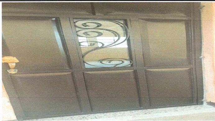
Foto 2: Sustrución de puerta
