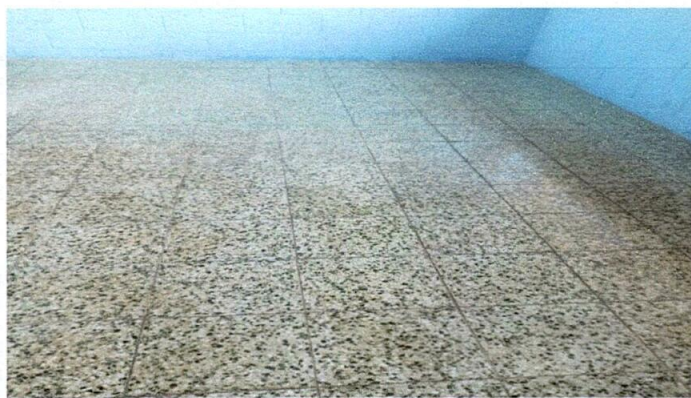
Foto 4: Sustrución de piso
