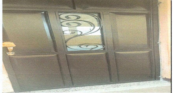
Foto 2: Sustitución de Puertas
