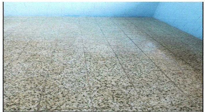
Foto 4: Sustitución de Piso
