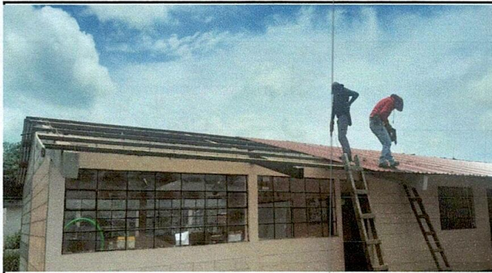
Foto 1: Sustitución de Lámina
