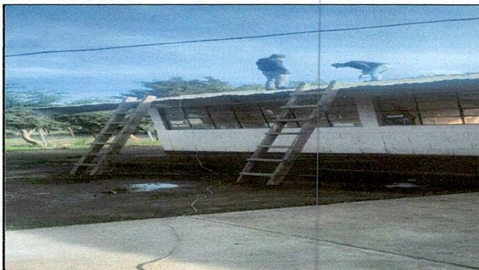
Foto 3: Sustitución de Estructura de Soporte
