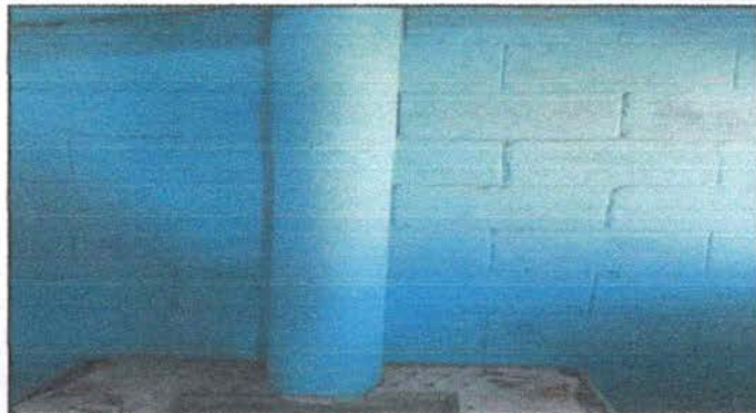
Foto 2: SUSTITUCIÓN DE CHIMENEA DE CONCRETO (TUBOS)
