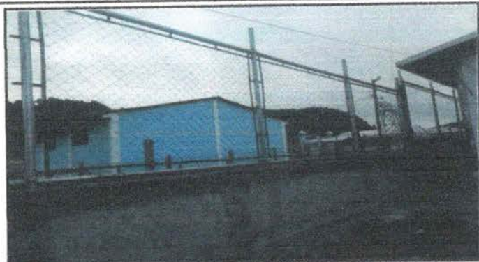
Foto 2: REPARACIÓN DE MURO PERIMETRAL DE BLOCK CON TUBOS HG Y MALLA GALVANIZADA, SOLERAS INTERMEDIAS Y COLUMNAS
