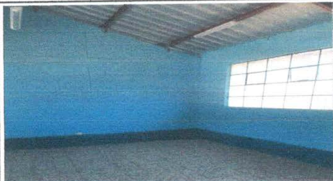
Foto 1: PINTURA A MUROS INTERIORES
