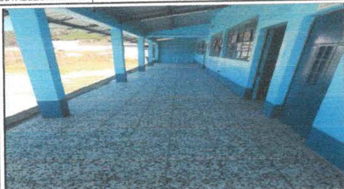
Foto 1: SUSTITUCIÓN DE PISO DE GRANITO
