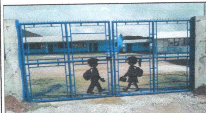
Foto 3: MANTENIMIENTO A PORTÓN DE METAL
