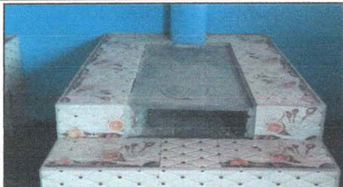
Foto 1: SUSTITUCIÓN DE PLANCHA DE 3 HORNILLAS
