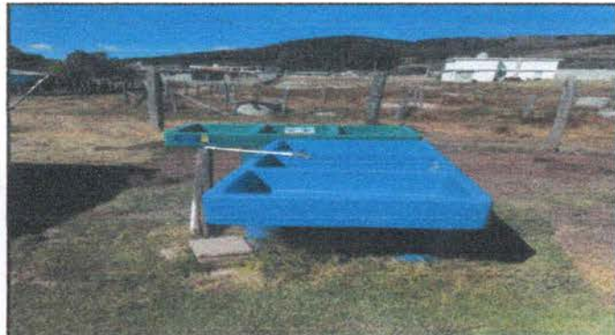
Foto 4: SUSTITUCIÓN DE PILAS PLÁSTICAS DE DOS LAVADEROS
