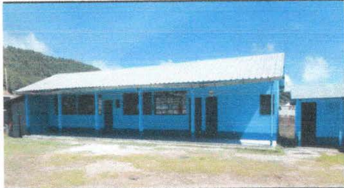
Foto 2: PINTURA EN MUROS EXTERIORES
