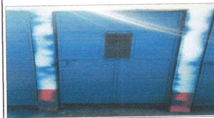
Foto 5: SUSTITUCIÓN DE PUERTA EN SERVICIO SANITARIO
