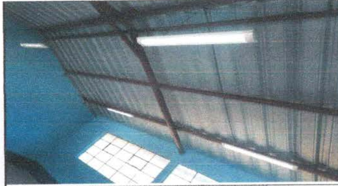
Foto 4: SUSTITUCIÓN DE LAMPARAS LED Y SUSTITUCIÓN DE CABLEADO ELÉCTRICO
