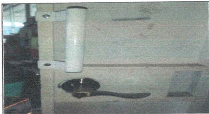
Foto 3: SUSTITUCIÓN DE CHAPA
