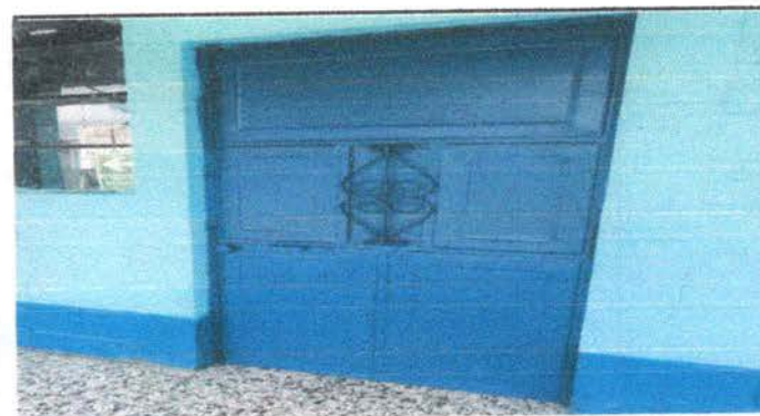
Foto 4: MANTENIMIENTO A ESTRUCTURA (LIJADO, CAMBIO DE TUBO, REDUCCIÓN DE TAMAÑO Y APLICACIÓN DE PINTURA)
