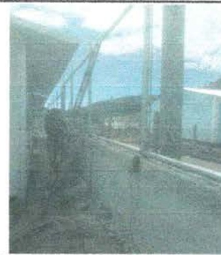
Foto 2: REPARACIÓN DE MURO PERIMETRAL DE BLOCK CON TUBO HG Y MALLA GALVANIZADA, SOLERAS INTERMEDIAS Y COLUMNAS
