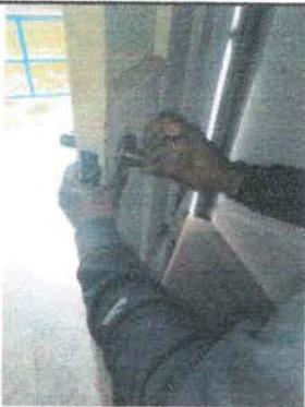
Foto 3: SUSTITUCIÓN DE CHAPA
