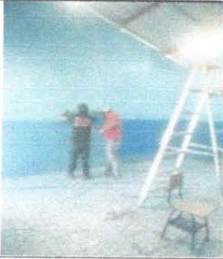
Foto1: PINTURA EN MUROS INTERIORES
