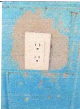
Foto 5: SUSTITUCIÓN DE TOMACORRIENTES E INTERRUPTORES DOBLES
