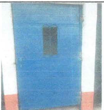
Foto 5: SUSTITUCIÓN DE PUERTA EN SERVICIO SANITARIO
