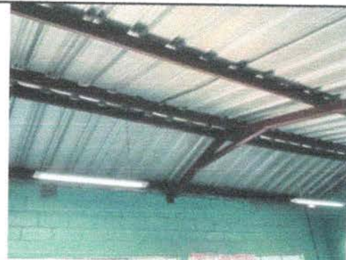
Foto 4: SUSTITUCIÓN DE LAMPARAS LED Y SUSTITUCIÓN DE CABLEADO ELÉCTRICO
