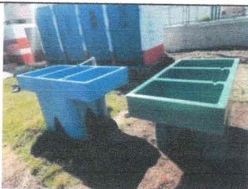
Foto 4: SUSTITUCIÓN DE PILA PLÁSTICA DE 2 LAVADEROS
