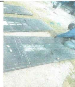
Foto 4: MANTENIMIENTO A ESTRUCTURA (LIJADO, CAMBIO DE TUBO, REDUCCIÓN DE TAMAÑO Y APLICACIÓN DE PINTURA)
