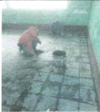
Foto 1: SUSTITUCIÓN DE PISO DE GRANITO
