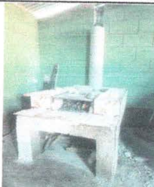
Foto 2: SUSTITUCIÓN DE CHIMENEA DE CONCRETO (TUBOS)
