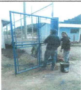
Foto 3: MANTENIMIENTO A PORTON DE METAL
