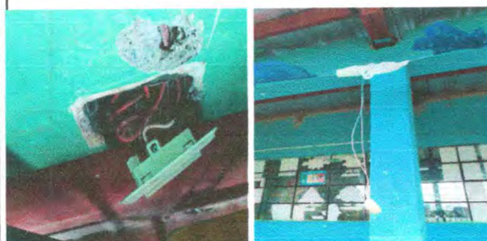
Foto 5: SUSTITUCIÓN DE TOMACORRIENTES E INTERRUPTORES DOBLES
