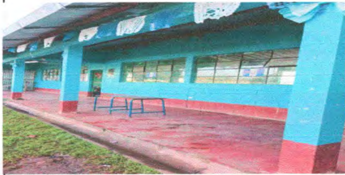
Foto 2: PINTURA EN MUROS EXTERIORES
