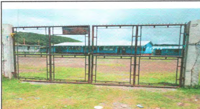
Foto 3: MANTENIMIENTO A PORTONES DE METAL
