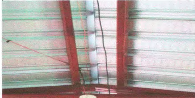
Foto 4: SUSTITUCIÓN DE LAMPARAS LED Y SUSTITUCIÓN DE CABLEADO ELÉCTRICO
