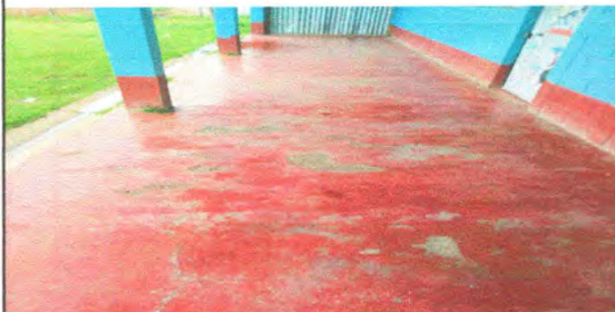
Foto 1: SUSTITUCIÓN DE PISO DE GRANITO
