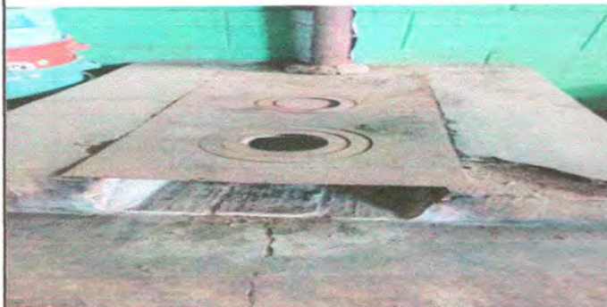
Foto 1: SUSTITUCIÓN DE PLANCHA DE 3 HORNILLAS
