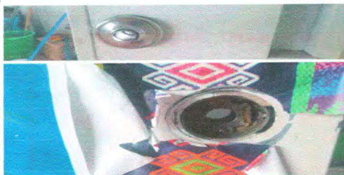
Foto 3: SUSTITUCIÓN DE CHAPA
