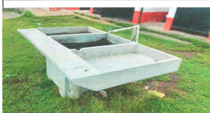
Foto 4: SUSTITUCIÓN DE PILA DE CEMENTO DE 2 LAVADEROS
