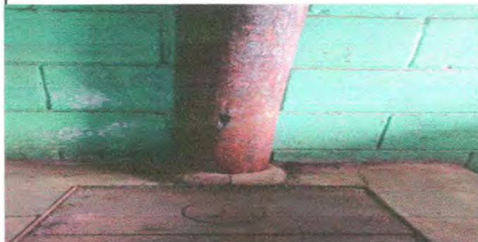
Foto 2: SUSTITUCIÓN DE CHIMENEA DE CONCRETO (TUBOS)
