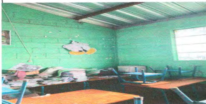
Foto1: PINTURA EN MUROS INTERIORES
