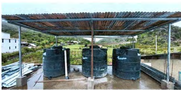
Foto 3: Sustrucción de estructura de soporte de madera por metal del area del tinaco
