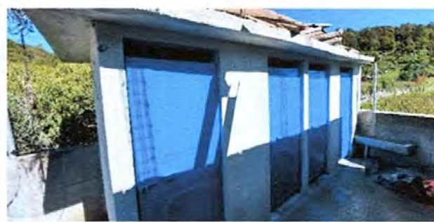
Foto 8: Sustitución de puertas de servicios sanitarios
