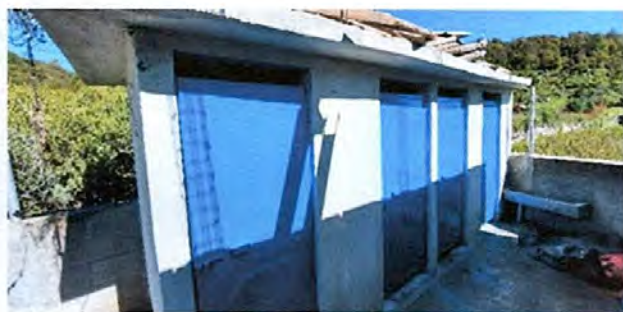
Foto 9: Sustitución de lámina por lámina troquelada A 100 Aluzinc calibre 26 de 12 pies del área de baños
