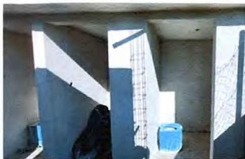
Foto 7: Sustitución de estructura de baños
