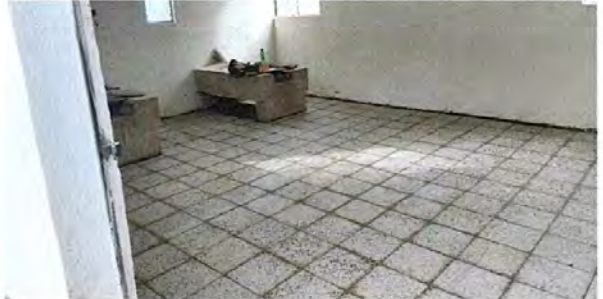
Foto 4: Sustrucción de piso de cemento por piso de granito en cocina
