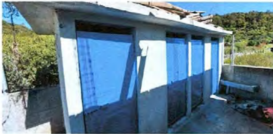
Foto 1: Sustrucción y mejoramiento de pared de baños
