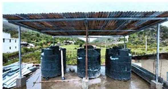
Foto 10: Sustitución de lámina por lámina troquelada A 100 Aluzinc calibre 26 de 12 pies del área del tinaco
