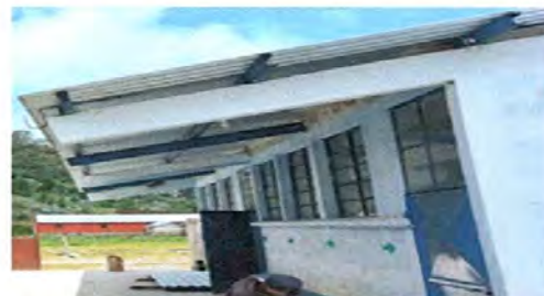
Foto 6: Mejoramiento de pared para colocación de tabiques.
