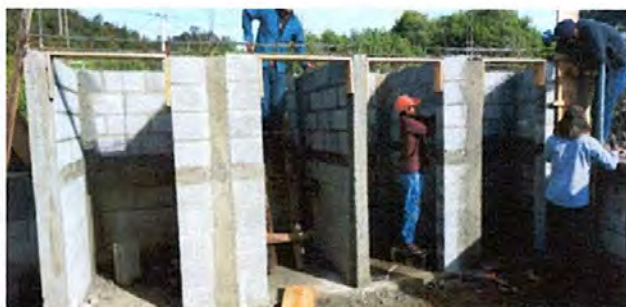
Foto 7: Sustitución de estructura de baños
