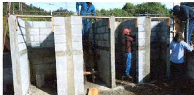
Foto 8: Sustitución de puertas de servicios sanitarios
