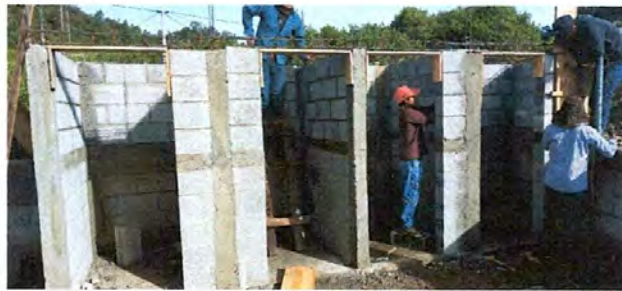
Foto 1: Sustitución y mejoramiento de pared de baños
