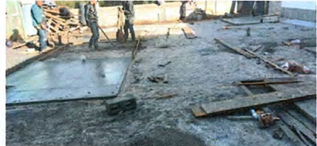
Foto 2: Sustitución de piso de torta de concreto.
