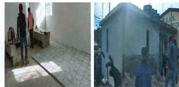
5. Repello y cernido de paredes de cocina.
