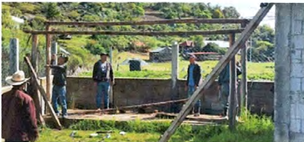
Foto 3: Sustitución de estructura de soporte de madera por metal del area del tinaco
