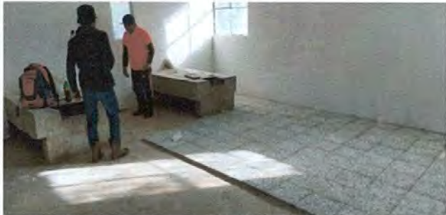
Foto 4: Sustitución de piso de cemento por piso de granito en cocina
