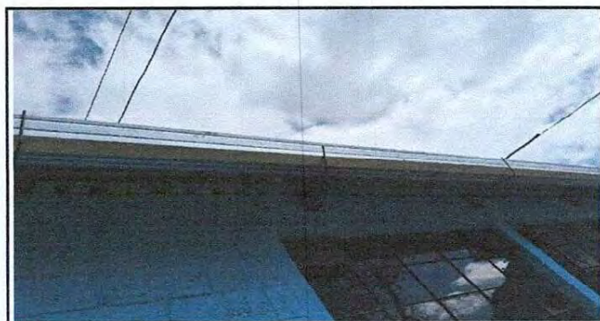
Foto 6: Instalación de canales de metal.
