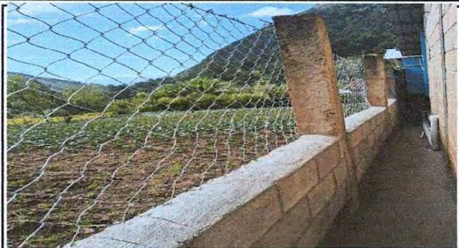
Foto 7: Colocación de malla en muro.
