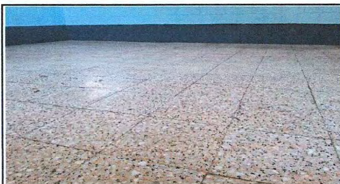
Foto 9: Colocación de granito en aula.
