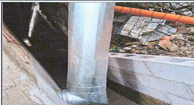
Foto13: Colocación de chimenea de metal en cocina.
