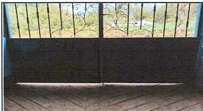
Foto 4: Pintura de Portón.
