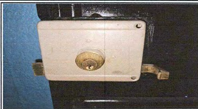
Foto 14: Colocación de chapa Yale.
