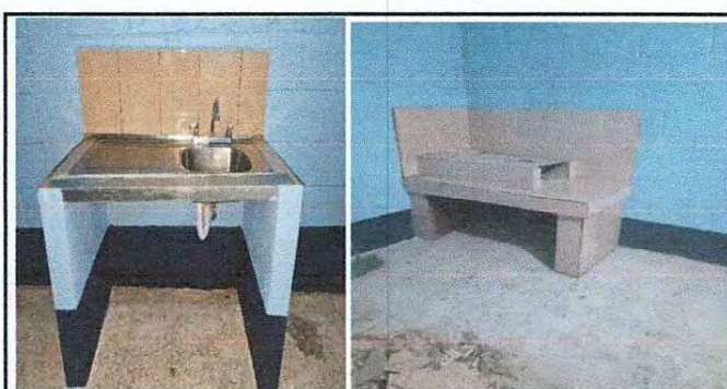
Foto 18: Instalación de cerámico en lavatrastos. Y mejoramiento de estufa rural.
