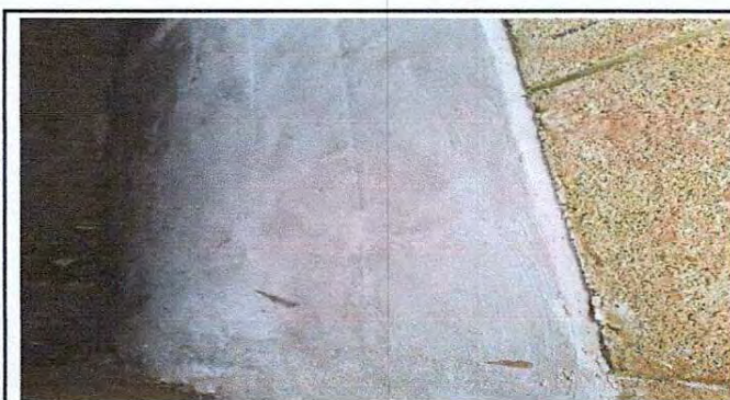
Foto 16: Repello de pared exterior.
