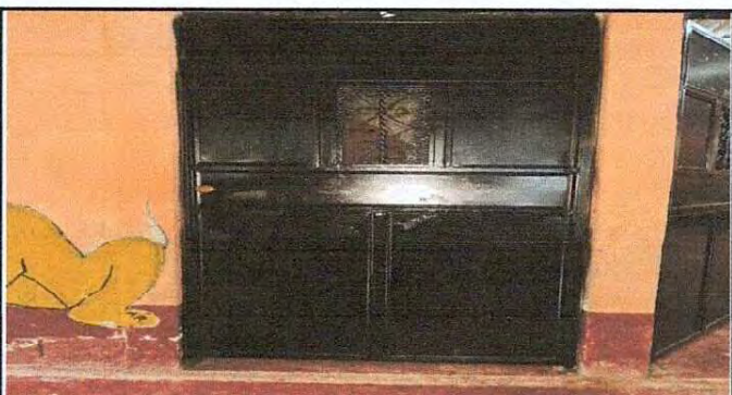
Foto 3: iniciando a pintar puertas.
