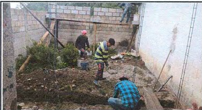
Foto 13: Inicio de construcción y mejoramiento de aula.
