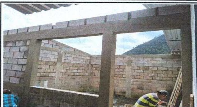
Foto 2: Tallando columnas y ventana.
