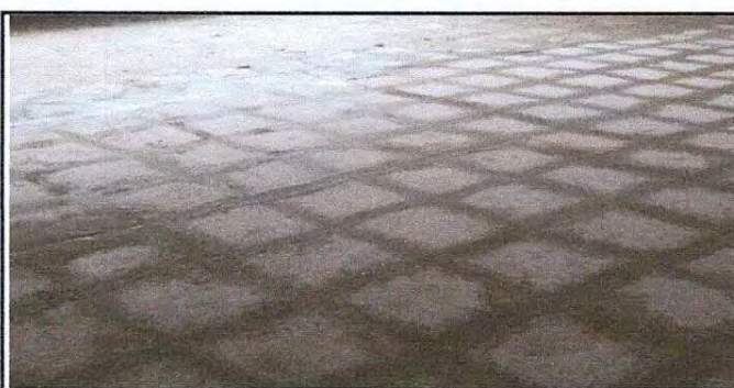
Foto 17: Colocación de piso granito.
