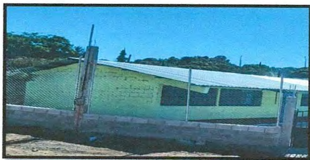
Foto 3: REPARACION DE MURO PERIMETRAL
