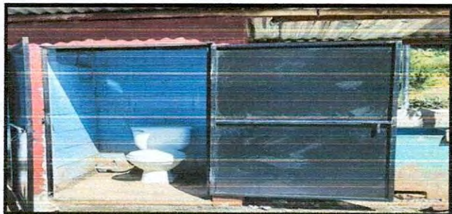
Foto1: SUSTITUCIÓN DE SANITARIOS
