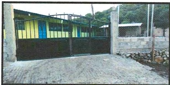
Foto 5: SUSTITUCION DE PORTÓN
