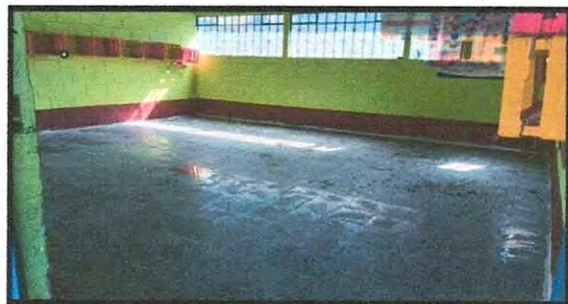
Foto1: SUSTITUCION DE PISO POR PISO GRANITO EN AULAS
