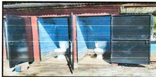
Foto 2: SUSTITUCION DE INODOROS
