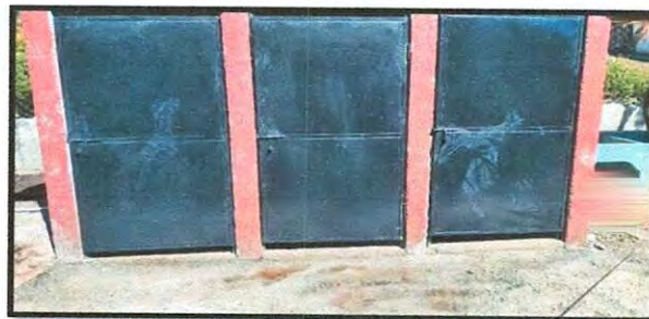
Foto 6: SUSTITUCION DE PUERTAS
