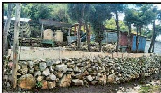
Foto 4: REPARACIÓN MURO PERIMETRAL
