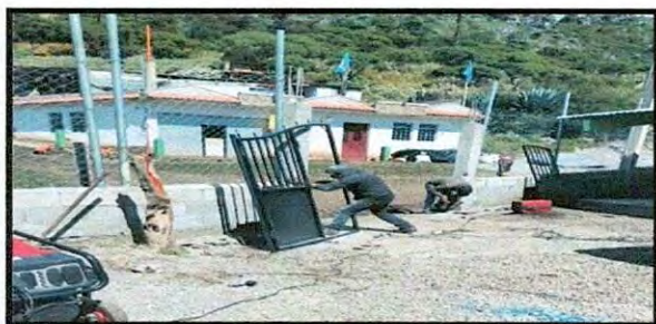
Foto 5: SUSTITUCION DE PORTÓN
