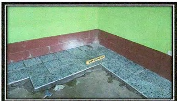
Foto1: SUSTITUCION DE PISO POR PISO GRANITO EN AULAS
