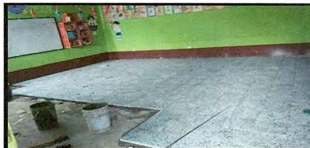
Foto 2: SUSTITUCION DE PISO POR PISO GRANITO
