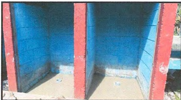
Foto1: SUSTITUCIÓN DE SANITARIOS
