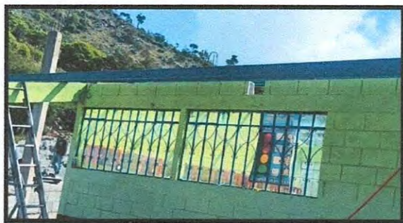
FOTO 3: SUSTITUCION DE CANAL PVC
