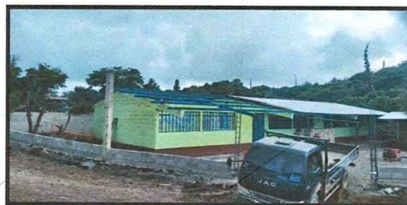
FOTO 4: SUSTITUCION DE TECHO
