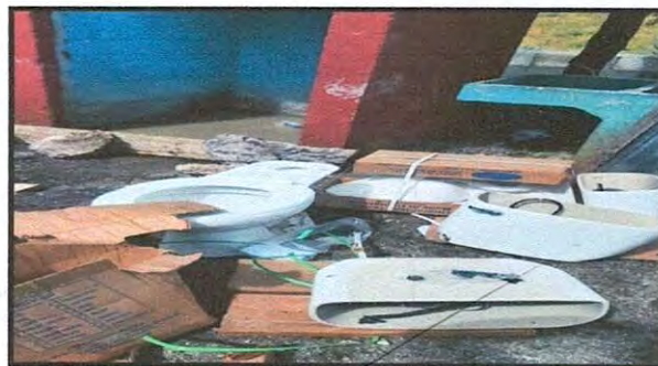
Foto 2: SUSTITUCION DE INODOROS
