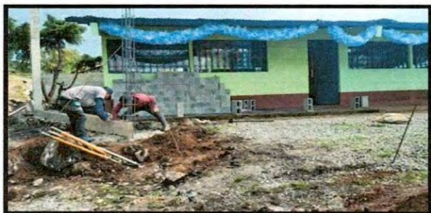
Foto 3: REPARACION DE MURO PERIMETRAL
