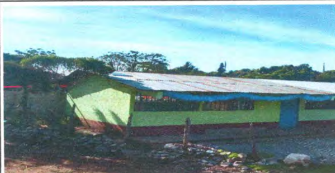
FOTO 4: SUSTITUCIÓN DE TECHO
