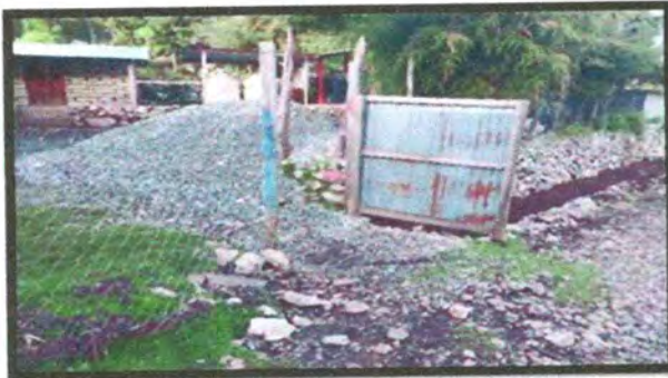
Foto 5: SUSTITUCION DE PORTÓN
