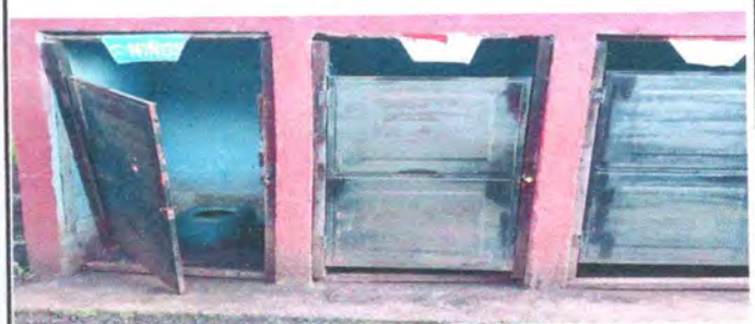
Foto 6: SUSTITUCION DE PUERTAS
