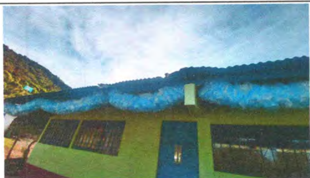
FOTO 3: COLOCACIÓN DE CANAL PVC
