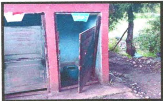
Foto1: SUSTITUCIÓN DE SANITARIOS
