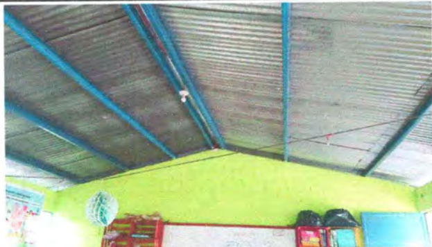
FOTO 5: SUSTITUCIÓN DE ESTRUCTURA DE METAL
