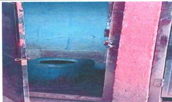
Foto 2: SUSTITUCION DE INODORO
