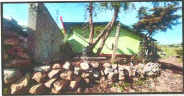
Foto 3: REPARACION DE MURO PERIMETRAL
