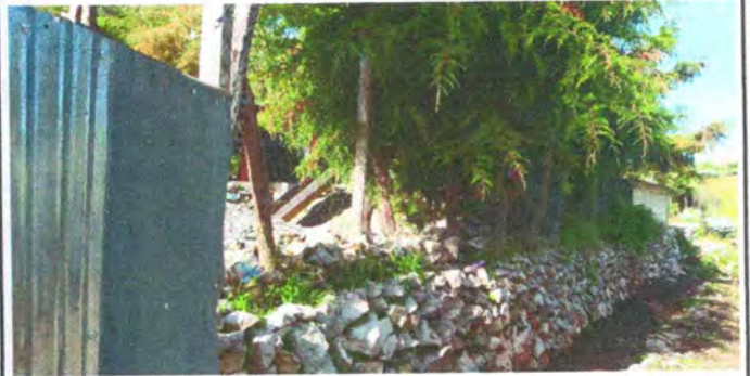
Foto 4: REPARACIÓN DE MURO PERIMETRAL
