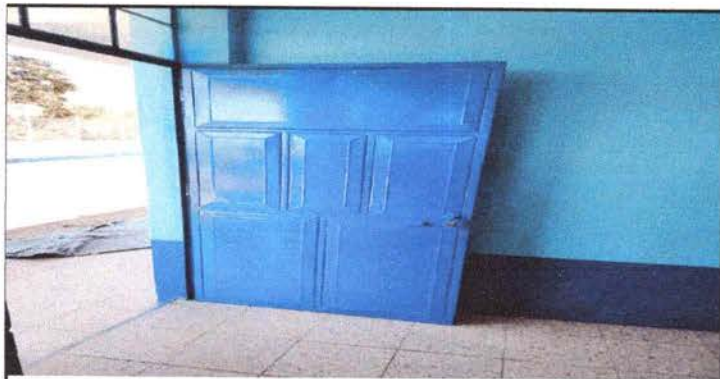
Foto 5: MANTENIMIENTO EN PUERTAS
