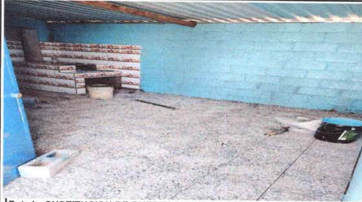
Foto 1: SUSTITUCION DE PUERTA Y LAMINA EN COCINA
