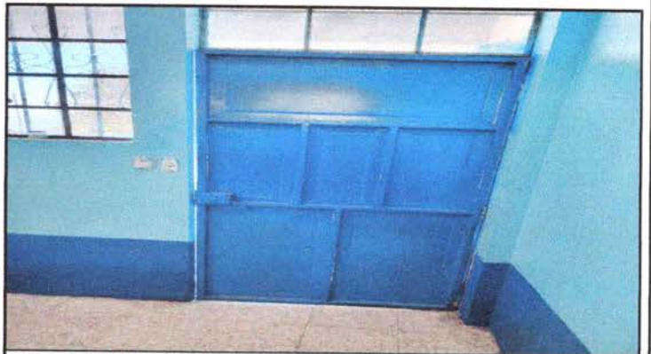
Foto 4: MANTENIMIENTO A PUERTAS
