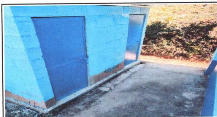
Foto 3: PUERTAS DE METAL
