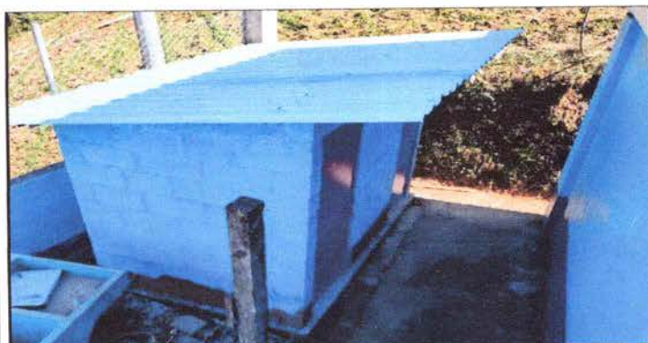
Foto 5: SUSTITUCIÓN LÁMINA EN BAÑOS Y PUERTAS
