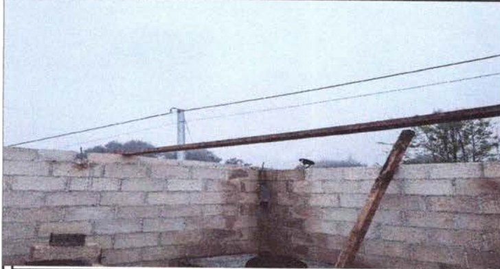
Foto 1: SUSTITUCION DE PUERTA Y LAMINA EN COCINA
