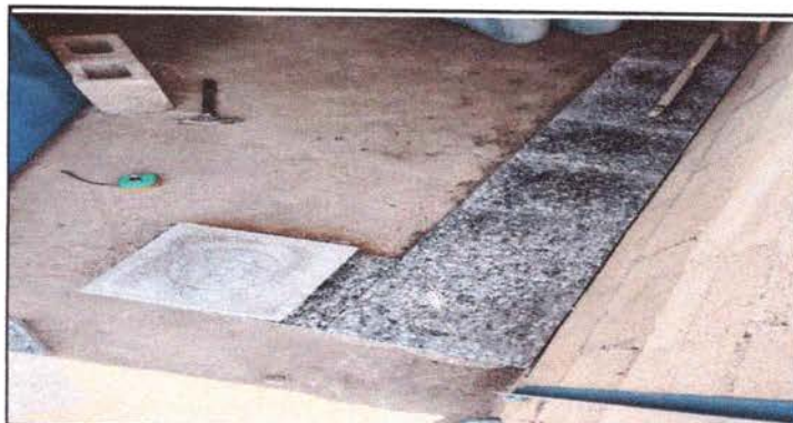
Foto 6: SUSTITUCION DE PISO DE CONCRETO POR PISO DE GRANITO
