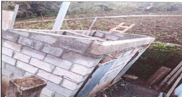
Foto 5: SUSTITUCIÓN LÁMINA EN BAÑOS Y PUERTAS
