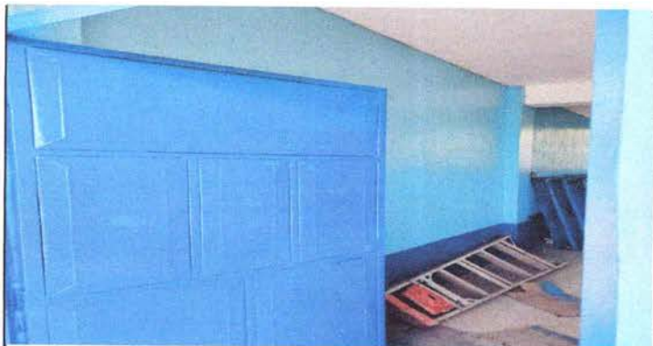
Foto 5: MANTENIMIENTO EN PUERTAS
