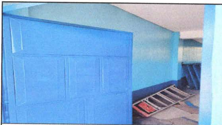
Foto 4: MANTENIMIENTO A PUERTAS
