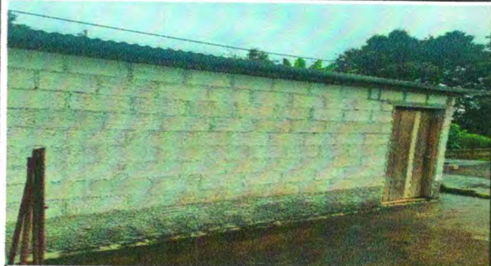
Foto1: SUSTITUCION DE PUERTA Y LAMINA EN COCINA
