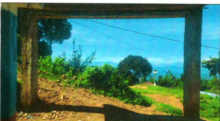
Foto 4: PUERTAS DE METAL(PORTÓN)
