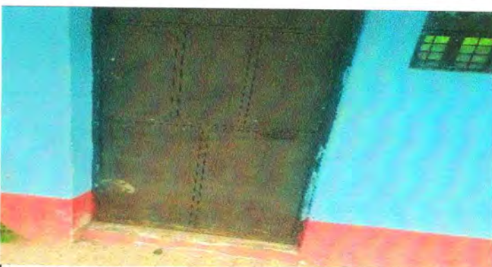
Foto 4: MANTENIMIENTO A PUERTAS
