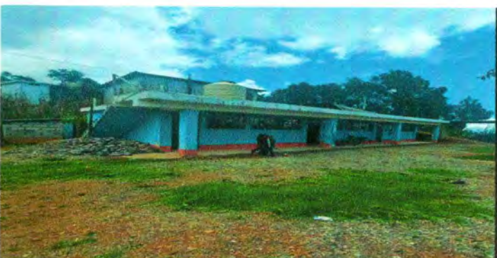
Foto 6: PINTURA EN EXTERIORES
