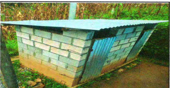
Foto 5: SUSTITUCIÓN LÁMINA EN BAÑOS Y PUERTAS
