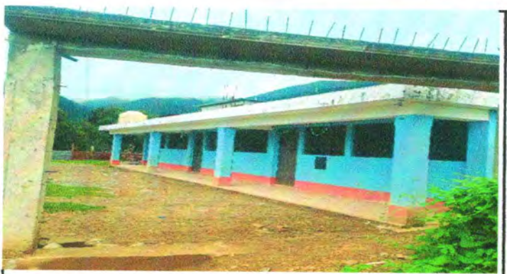
Foto 3: INSTALACIÓN Y FABRICACION DE BALCONES EN VENTANAS
