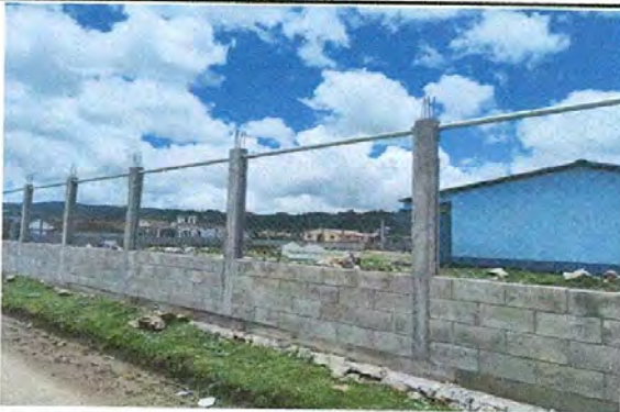
Foto 3: REPARACIÓN DE MURO PERIMETRAL DE BLOCK CON TUBO HG Y MALLA GALVANIZADA, SOLERAS INTERMEDIAS Y COLUMNAS
