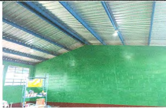
Foto 6: APLICACIÓN DE PINTURA EN MUROS INTERIORES
