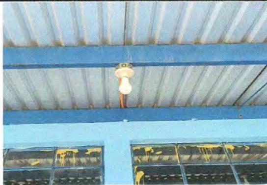
Foto 4: SUSTITUCIÓN DE DUCTO ELÉCTRICO MÁS ACCESORIOS
