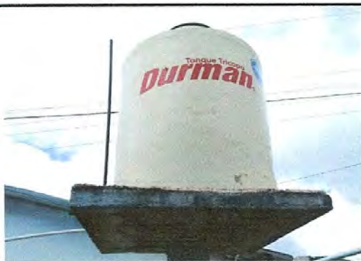
Foto 5: SUSTITUCIÓN DE DEPÓSITO DE AGUA 1,100 LT
