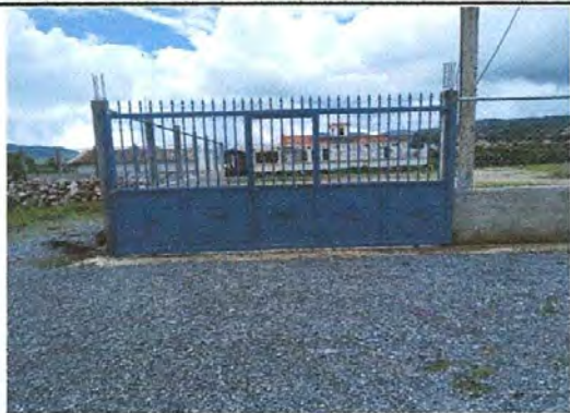
Foto 1: SUSTITUCIÓN DE PORTÓN DE METAL
