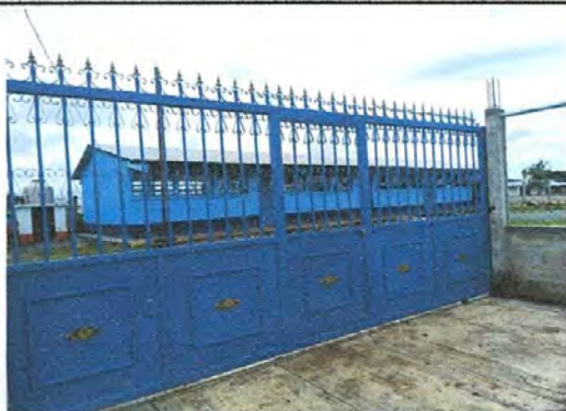
Foto1: SUSTITUCIÓN DE PORTÓN DE METAL
