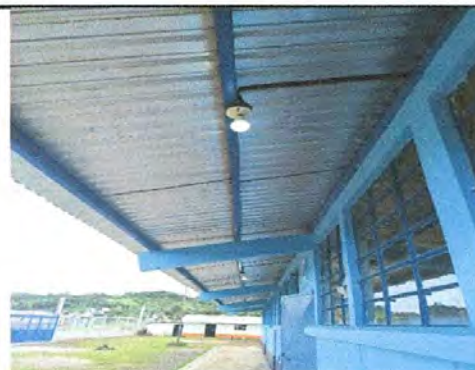
Foto 4: SUSTITUCIÓN DE DUCTO ELÉCTRICO MÁS ACCESORIOS
