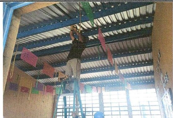
Foto 4: SUSTITUCIÓN DE DUCTO ELÉCTRICO MÁS ACCESORIOS
