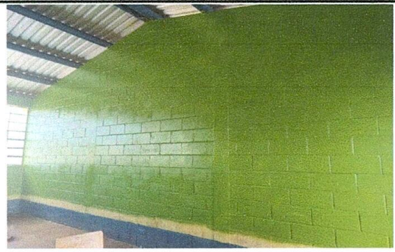
Foto 6: APLICACIÓN DE PINTURA EN MUROS INTERIORES
