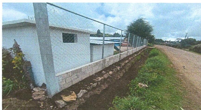
Foto 4: Reparación de muro perimetral
