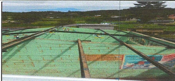
Foto1: Sustitución de Estructura de madera por metal
