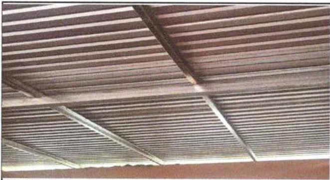
Foto 3: Techo de aula completamente restituído
