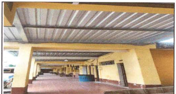
Foto 4: Techo de corredor restituído
