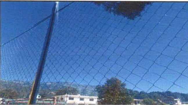
Foto 9: Cambio malla muro perimetral
