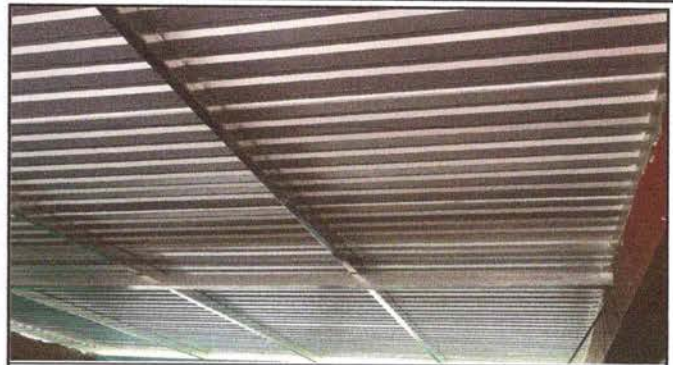
Foto 2: Techo completamente restaurado
