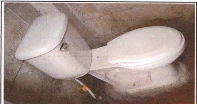
Foto 8: Sanitario alumnado sustituido
