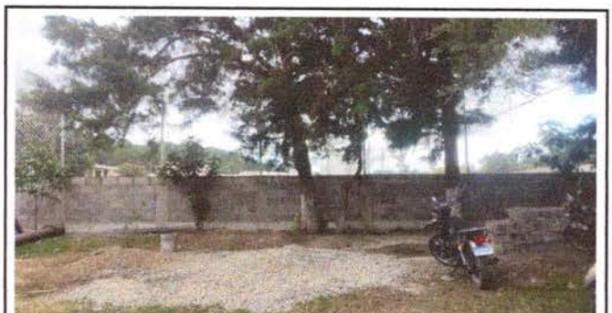
Foto 12: Muro perimetral sustituido
