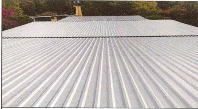
Foto1: Techo completamente restituído.
