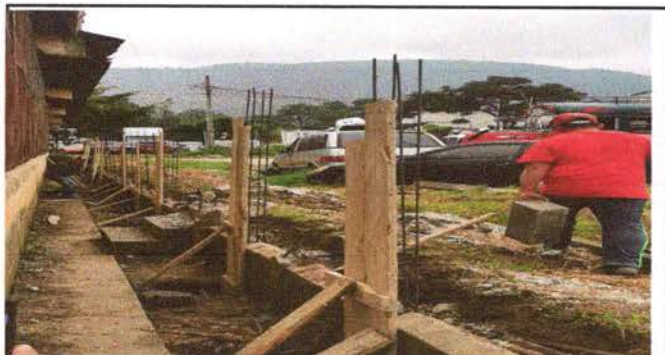
Foto 9: Fundición de solera de humedad.
