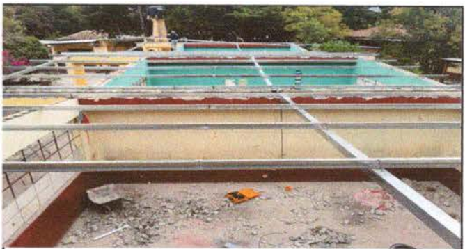
Foto 4: Costaneras instaladas
