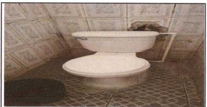
Foto 6: Instalación de sanitario
