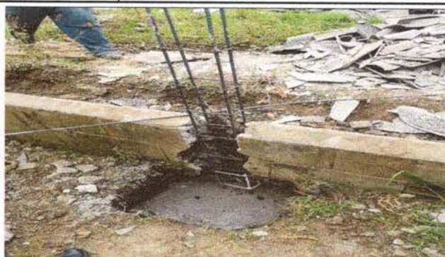
Foto 8: Fundición de zapatas.
