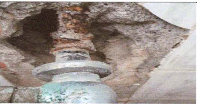
Foto 5: Cambio de tubo agua potable.
