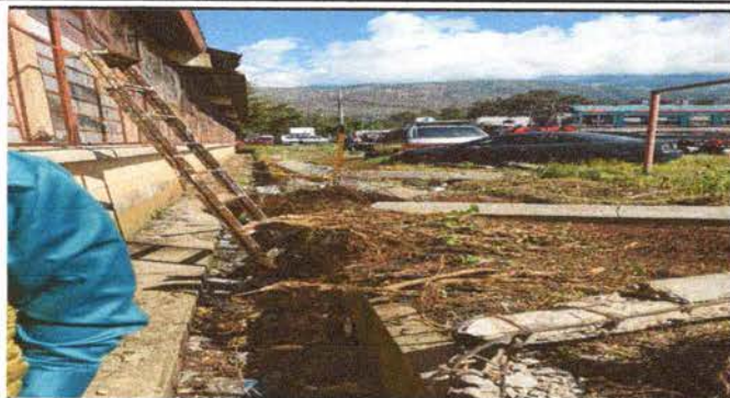
Foto 7: Derribación y escabación de muro perimetral.
