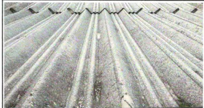
Foto 2: Sustitución de lámina por lámina, por lámina troquelada aluzin calibre 26
