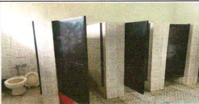
Foto 5: Sustitución de inodoros y accesorios
