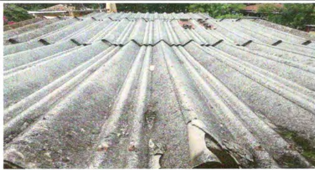
Foto1: Sustitución de lámina por lámina, por lámina troquelada aluzin calibre 26
