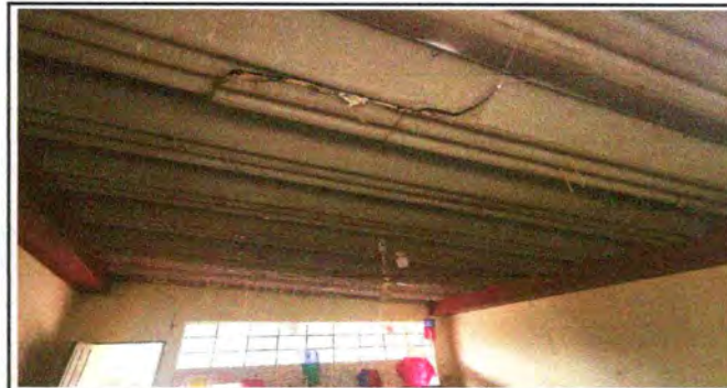
Foto 4: Mejoramiento de estructura de soporte de metal
