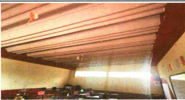
Foto 3: Mejoramiento de estructura de soporte de metal
