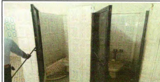
Foto 6: Sustitución de inodoros y accesorios
