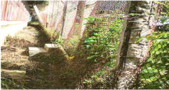
Foto 7: Sustitución de Muro Perimetral de block y malla, por block, tubo hg, malla galvanizada, soleras intermedias y columnas
