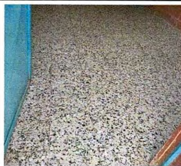
Foto 6: Sustitucion de torta de cemento por piso tipo granito de 1"
