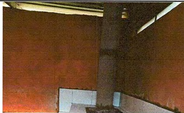
Foto 16: Sustrución de chimenea
