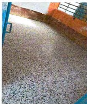
Foto 5: Sustitucion de torta de cemento por piso tipo granito de 1"
