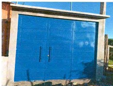
Foto 4: Sustitución de porton de metal
