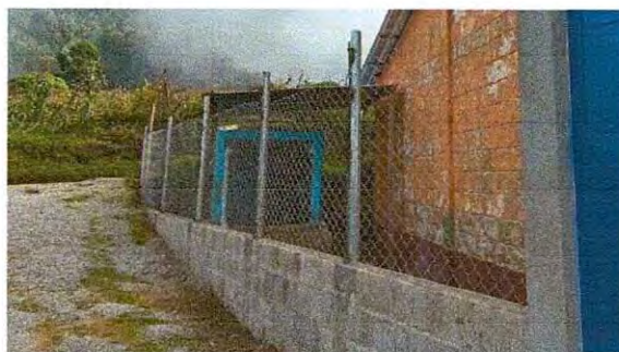
Foto 12: Sustrucion de cerco de malla y poste de madera, por tubo hg, malla galvanizada, block, soleras intermedias y columnas
