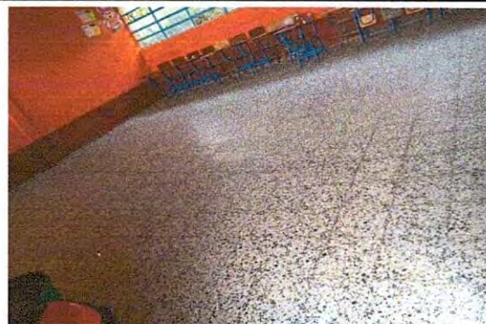
Foto 8: Sustrucion de torta de cemento por piso tipo granito de 1"
