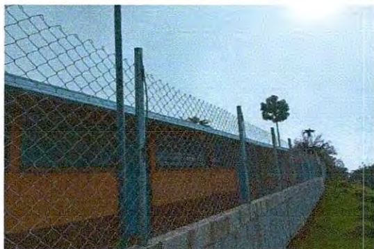
Foto 11: Sustrucion de cerco de malla y poste de madera, por tubo hg, malla galvanizada, block, soleras intermedias y columnas
