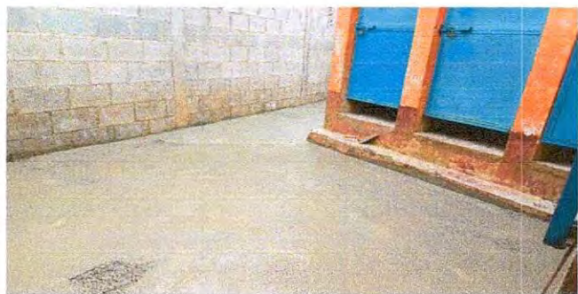
Foto 9: Reparación de piso de torta de cemento
