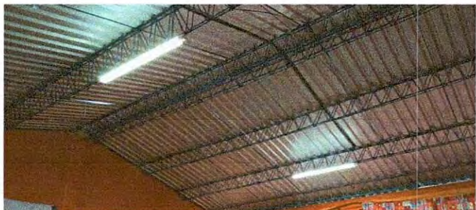
Foto13: Sustrución de focos ahorradores por lamparas Led
