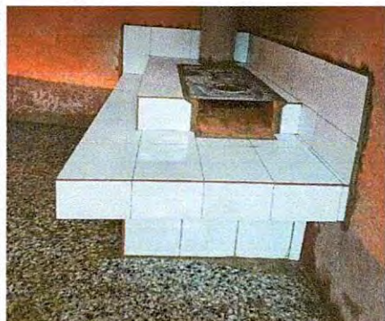
Foto 15: Sustrución de estufa rural e instalación de azulejo
