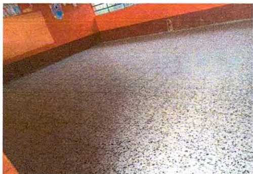
Foto7: Sustrucion de torta de cemento por piso tipo granito de 1"
