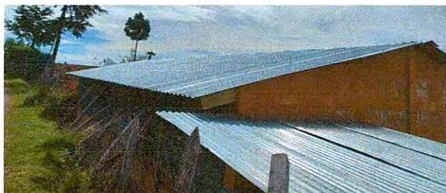
Foto 1: Sustitución de lámina, por lámina troquelada aluzinc calibre 26 y capote
