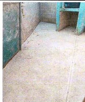
Foto 10: Reparación de piso de torta de cemento
