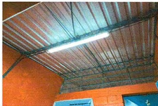
Foto 14: Sustrución de cableado electrico
