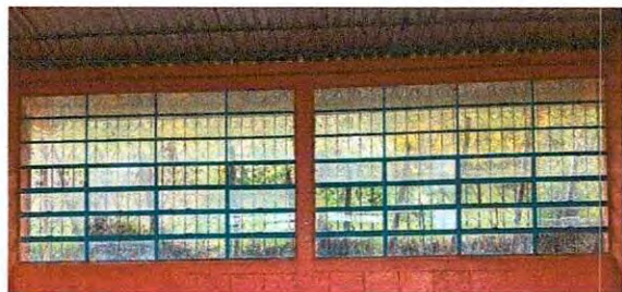
Foto 17: Sustrución de vidrios
