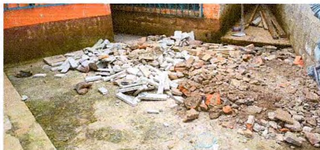
Foto 9: Reparación de piso de torta de cemento
