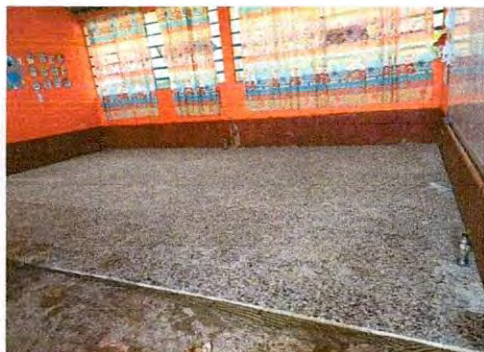
Foto 7: Sustrucción de torta de concreto por piso tipo granito de 1"
