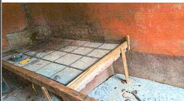
Foto 15: Sustrucción de estufa rural e instalación de azulejo
