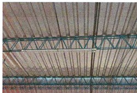
Foto 14: Sustrucción de cableado electrico
