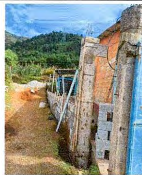
Foto 12: Sustrucción de cerco de malla y poste de madera, por tubo hg, malla galvanizada, block, soleras intermedias y columnas
