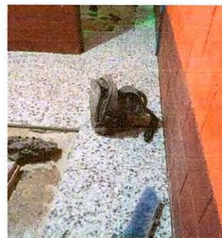
Foto 6: Sustitución de torta de concreto por piso tipo granito de 1"
