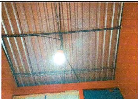
Foto 13: Sustrucción de focos ahorradores por lampara Led
