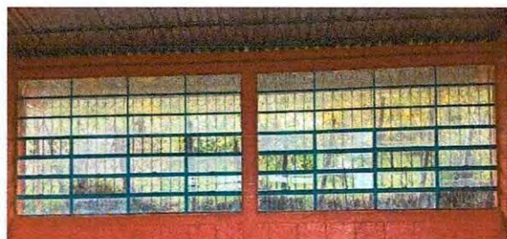
Foto 17: Sustrucción de Vidrios
