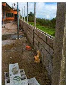
Foto 11: Sustrucción de cerco de malla y poste de madera, por tubo hg, malla galvanizada, block, soleras intermedias y columnas
