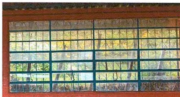
Foto 18: Sustrucción de Vidrios
