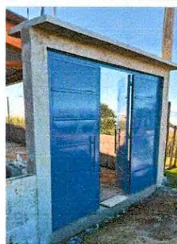
Foto 4: Sustitución de portón de metal
