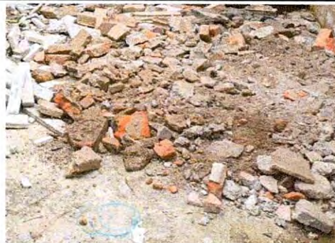
Foto 10: Reparación de piso de torta de cemento
