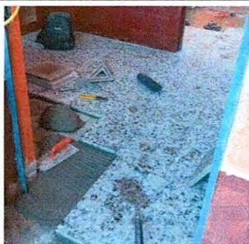
Foto 5: Sustitución de torta de concreto por piso tipo granito de 1"
