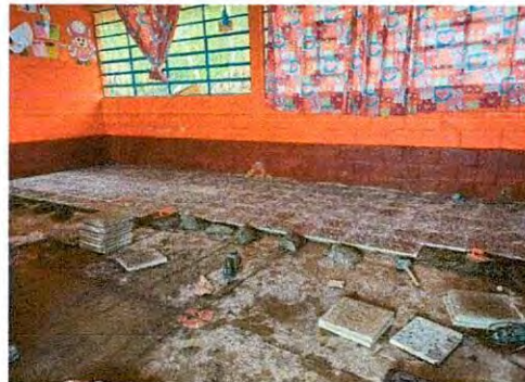
Foto 8: Sustrucción de torta de concreto por piso tipo granito de 1"
