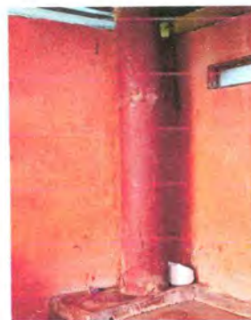
Foto 16 Sustrución de Chimenea
