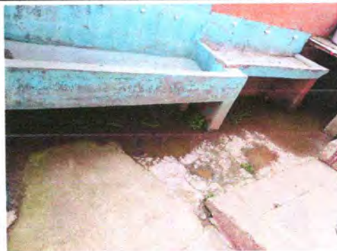
Foto 10: Reparación de piso de torta de cemento
