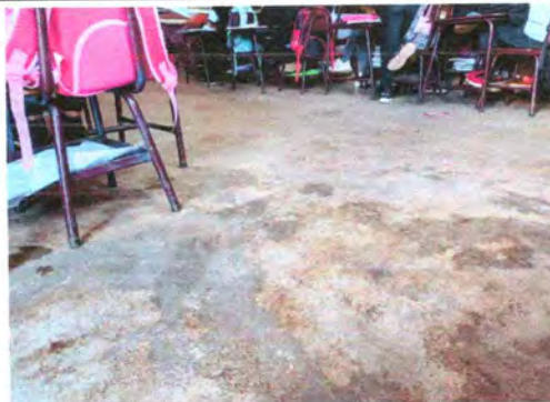
Foto 8: Sustitución de piso de torta de concreto por piso tipo granito de 1"
