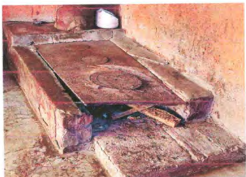
Foto 15: Sustrución de estufa rural e instalación de azulejo
