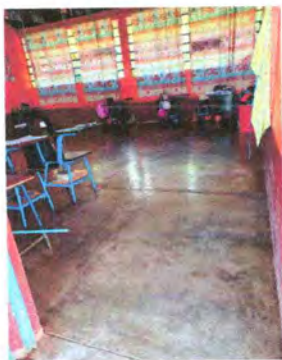
Foto 7: Sustitución de piso de torta de concreto por piso tipo granito de 1"
