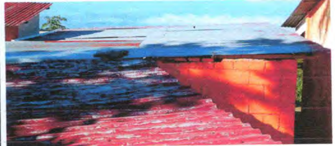
Foto 2: sustitución de lamina, por lamina troquelada aluzinc calibre 26
