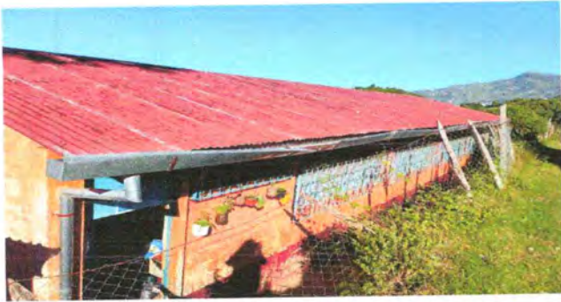
Foto 1: sustitucion de lamina, por lamina troquelada aluzinc calibre 26 y capote
