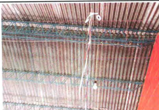
Foto 13: Sustrución de focos ahorradores por lamparas Led
