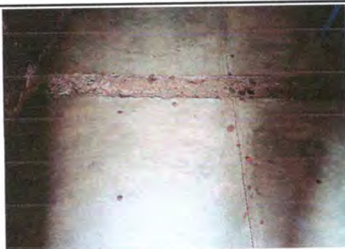
Foto 5: Sustitución de piso de torta de concreto por piso tipo granito de 1"
