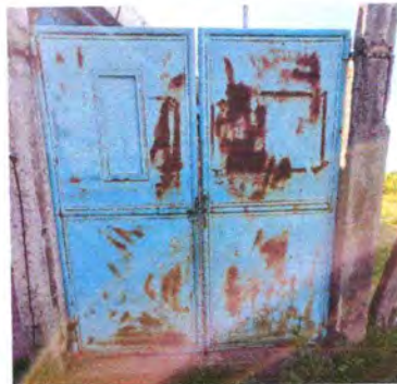
Foto 4: Sustitución de portón de metal
