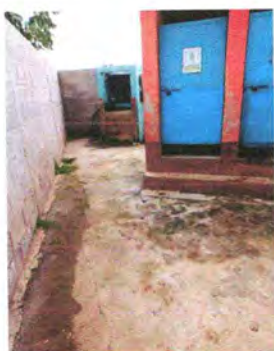
Foto 9: Reparación de piso de torta de cemento
