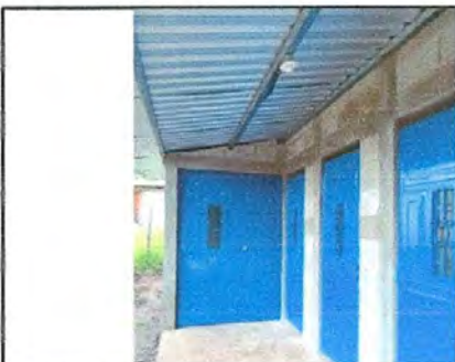
Estructura de Techo
