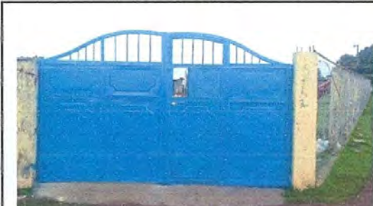
Sustitución de Portón de ingreso principal
