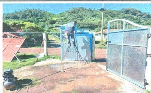
Instalación porton de ingreso principal
