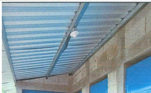
Estructura de techo
