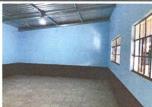
Foto 6: PINTURA DE PAREDES DE AULAS INTERNOS
