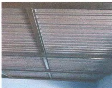
Foto 2: SUSTITUCIÓN DE ESTRUCTURA DE SOPORTE DE MADERA POR METAL DE AULAS Y BODEGA
