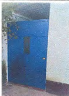
Foto 3: SUSTITUCIÓN DE PUERTA EN COCINA Y BODEGA
