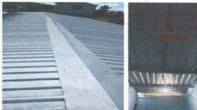
Foto1: SUSTITUCIÓN DE LÁMINA POR LÁMINA ZINCALUM CALIBRE 26 PARA AULAS Y BODEGA
