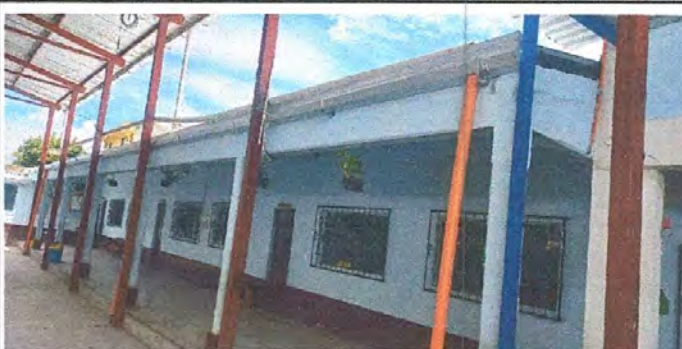
Foto 5: SUSTITUCIÓN DE CANAL DE METAL
