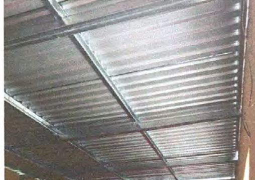
Foto 2: SUSTITUCIÓN DE ESTRUCTURA DE SOPORTE DE MADERA POR METAL DE AULAS Y BODEGA
