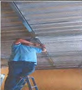
Foto7: Foto7: SUSTITUCIÓN DEL CABLEADO ELÉCTRICO
