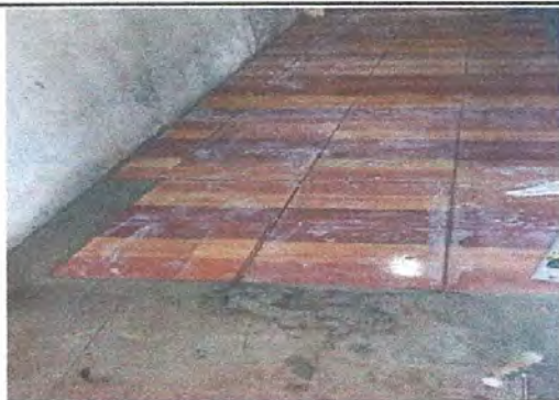
Foto 4: SUSTITUCIÓN DE PISO DE CONCRETO POR PISO CERÁMICO EN BODEGA
