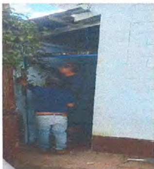
Foto 3: SUSTITUCIÓN DE PUERTA EN COCINA Y BODEGA
