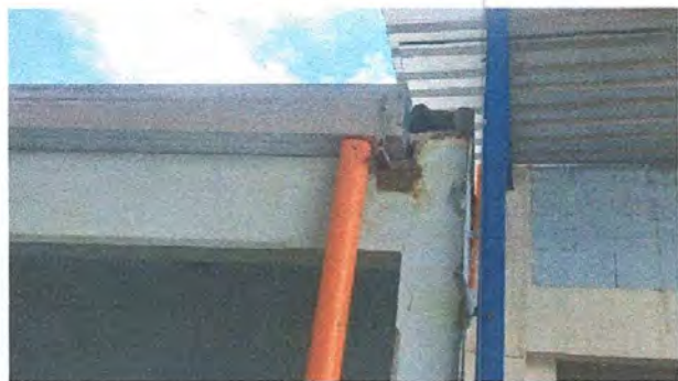
Foto 5: SUSTITUCIÓN DE CANAL DE METAL
