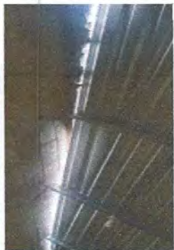
Foto 1: SUSTITUCIÓN DE LÁMINA POR LÁMINA ZINCALUM CALIBRE 26 PARA AULAS Y BODEGA
