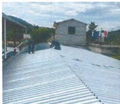
Foto 1: SUSTITUCIÓN DE LÁMINA POR LÁMINA ZINCALUM CALIBRE 26 PARA AULAS Y BODEGA
