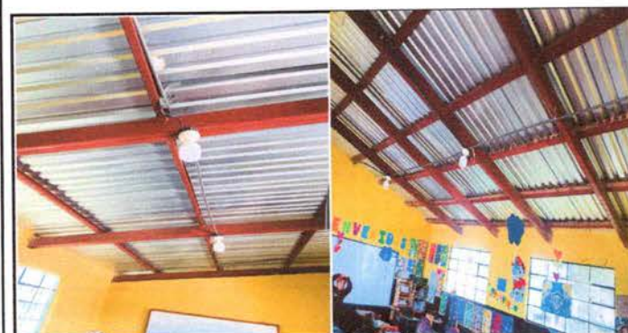
FOTO 11: Sustitución de Plafoneras
