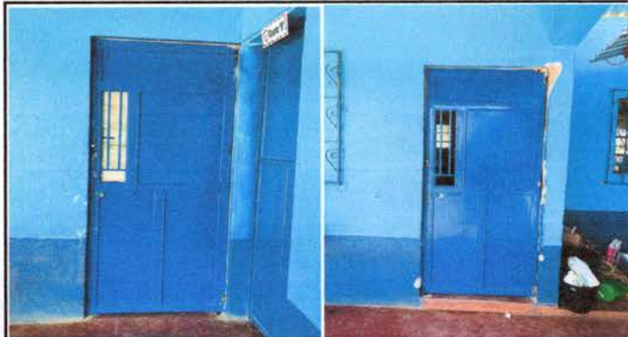
FOTO 2: Sustitución de Puerta de madera por metal
