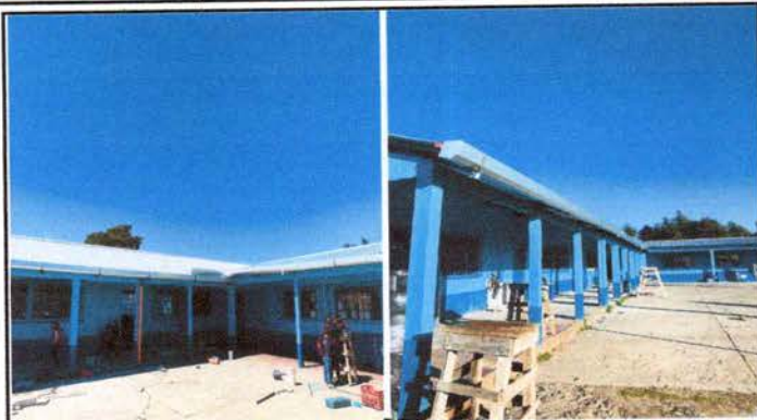
FOTO 7: Sustitución de Canal de Metal
