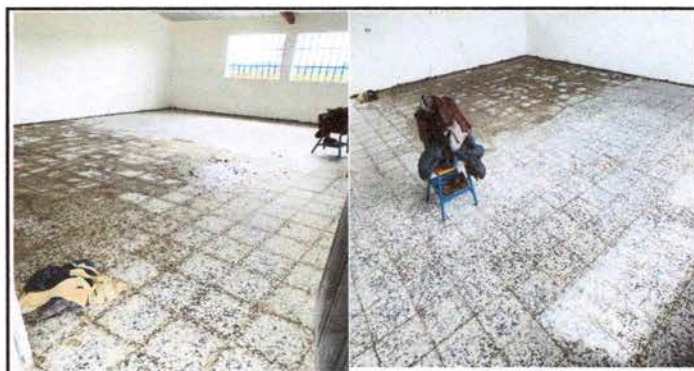
FOTO 6: Sustitución de Piso de Cemento Líquido por Piso de Granito
