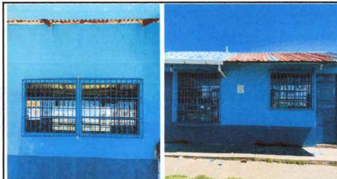
FOTO 4: Mejoramiento a balcones de metal
