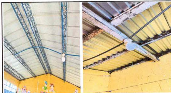
FOTO 10: Sustitución de focos ahorradores
