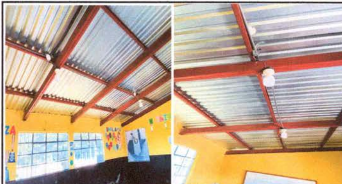
FOTO 16: Sustrucción de Cableado eléctrico
