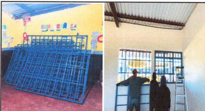
FOTO 3: Mejoramiento a estructura de metal de ventana
