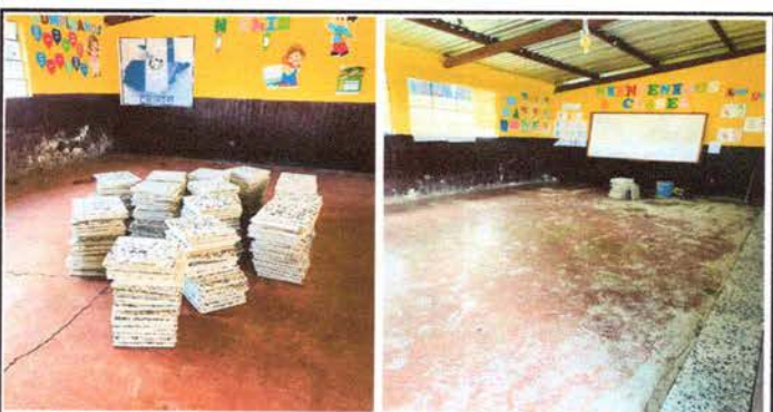
FOTO 5: Sustitución de piso de torta de Concreto por piso de Granito
