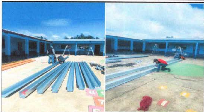
FOTO 7: Sustitución de Canal de Metal
