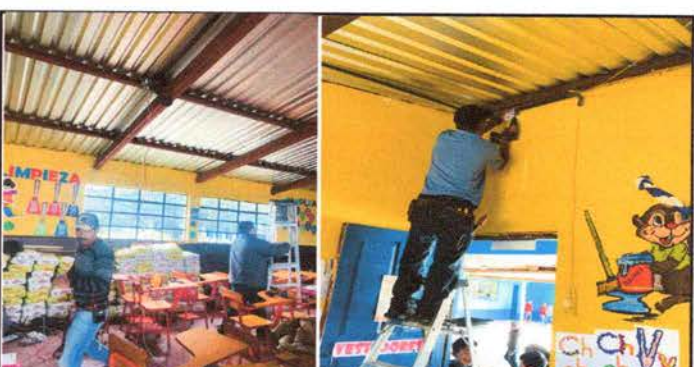
FOTO 12: Sustitución de interruptores dobles
