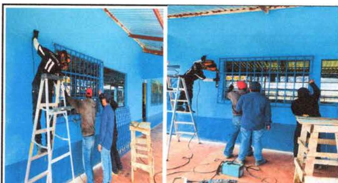
FOTO 4: Mejoramiento a balcones de metal
