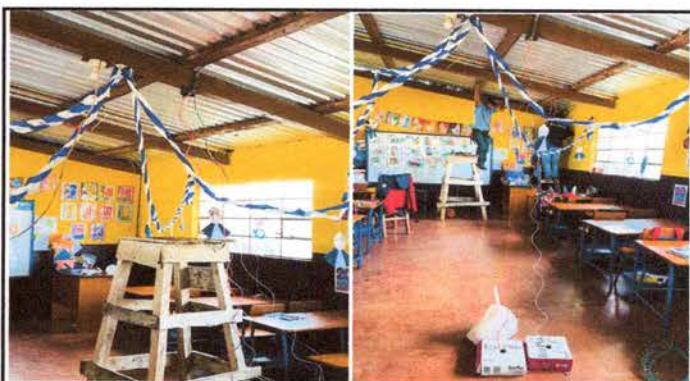
FOTO 16: Sustitución de Cableado eléctrico
