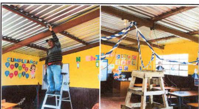
FOTO 10: Sustitución de focos ahorradores
