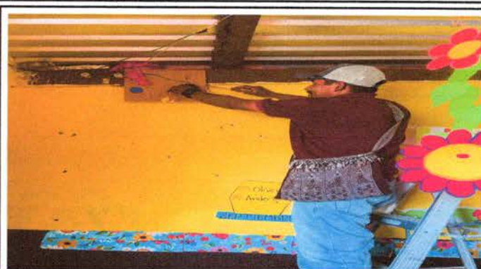
Foto 14: Sustitución de Flipones
