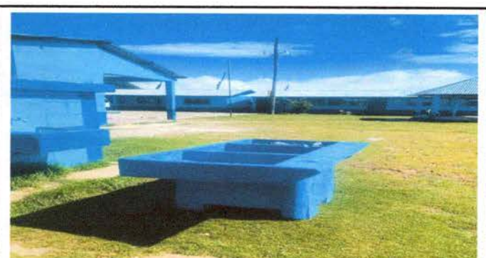
FOTO 18: Sustitución de pila de cemento de 2 lavaderos
