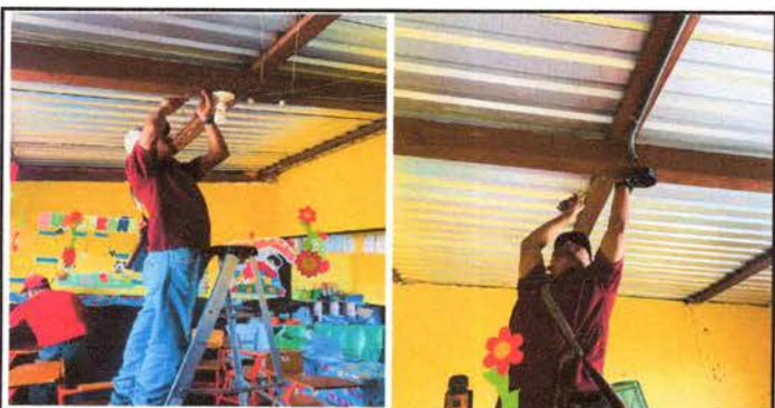
FOTO 11: Sustitución de Plafoneras
