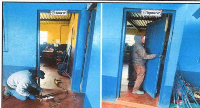
FOTO 2: Sustitución de Puerta de madera por metal
