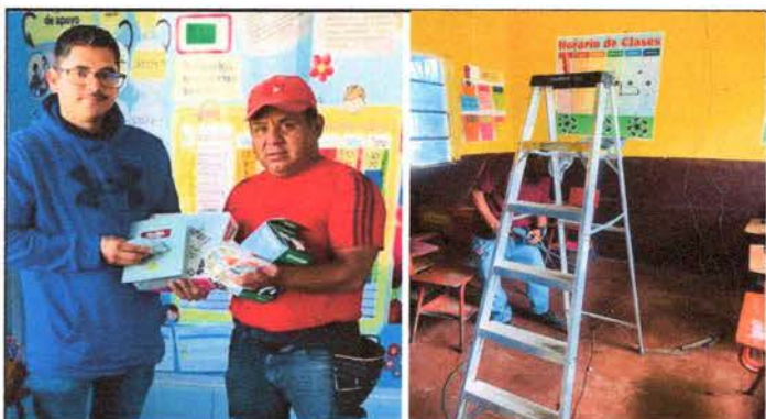
Foto 15: Sustitución de Tablero de Flipones
