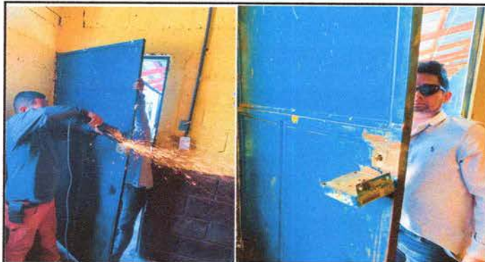
FOTO 1: Sustitución de chapas
