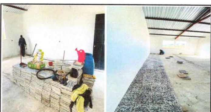
FOTO 6: Sustitución de Piso de Cemento Liquido por Piso de Granito
