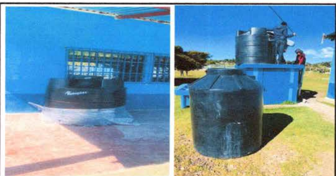
FOTO 17: Sustitución de deposito de agua 1,700 lt
