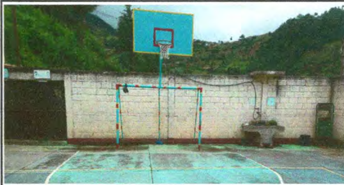
Foto 14: Pintura de muros exteriores
