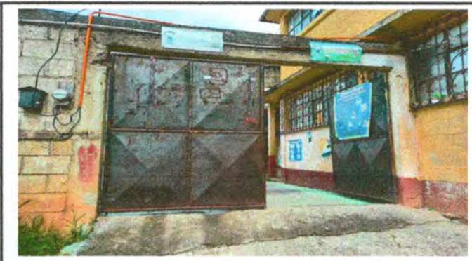
Foto 10: Mantenimiento de portones de metal (lijado, marco y pintura)
