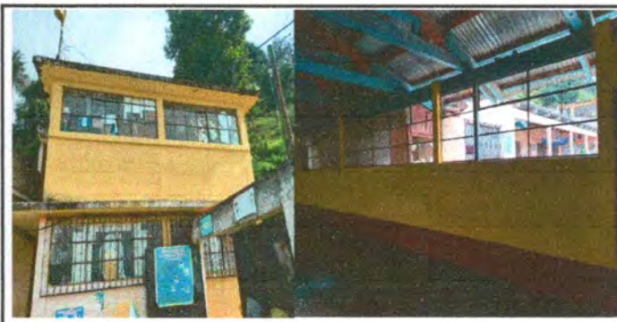
Foto 6: Sustitución de balcones de metal
