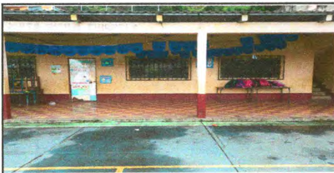
Foto 17: Pintura de muros exteriores
