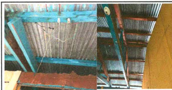
Foto 11: Sustitución de plafoneras
