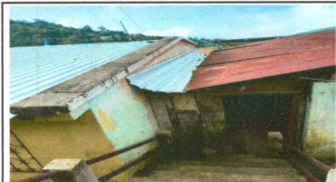
Foto 9: Sustitución de canal de pvc
