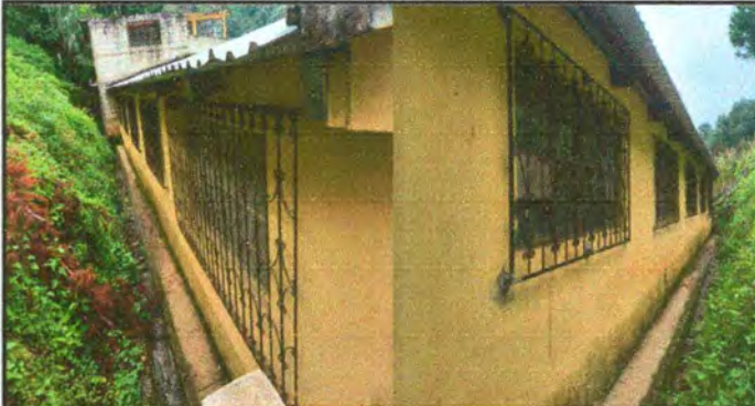
Foto 16: Pintura de muros exteriores
