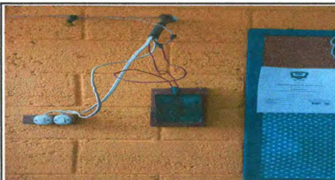
Foto 12: Sustitución de flapon general
