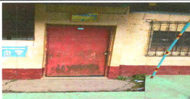
Foto 3: Sustitución de puerta de metal
