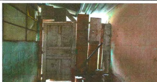
Foto 4: Sustitución de porton de metal
