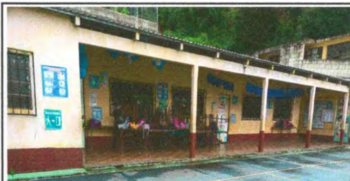
Foto 18: Pintura de muros exteriores
