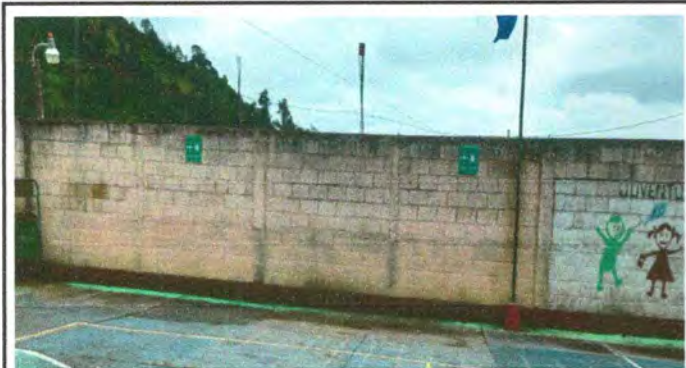
Foto 15: Pintura de muros exteriores
