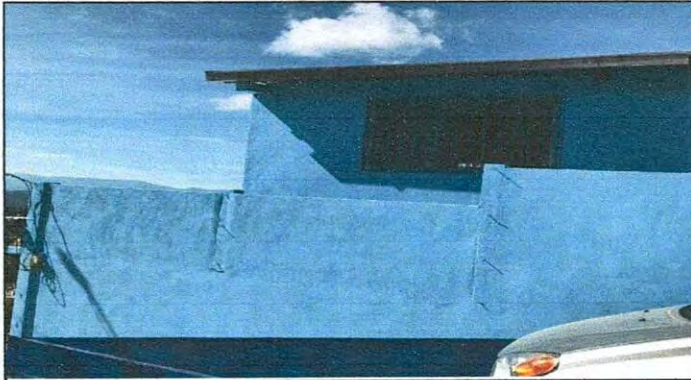
Foto 7: Reparación de muro perimetral
