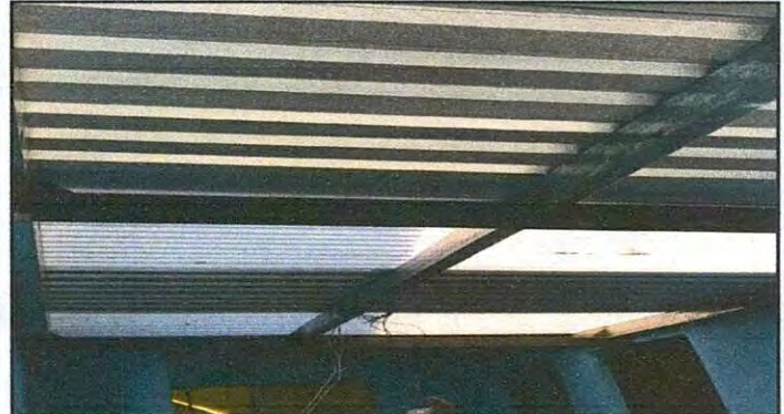
Foto 2: Cambio de Lámina por lámina troquelada y estructura de madera por metal
