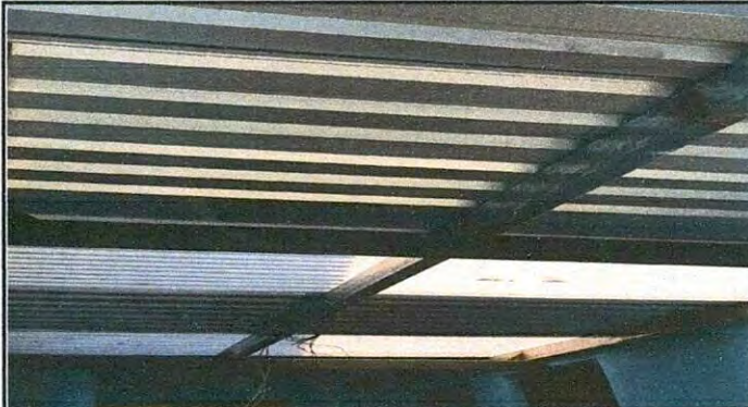
Foto 1: Cambio de Lámina por lámina troquelada y estructura de madera por metal
