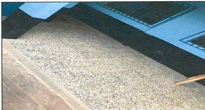
Foto 5: Sustitución de piso por piso de granito
