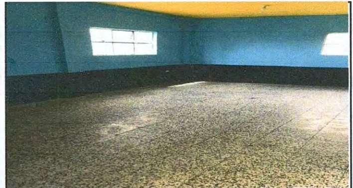
Foto 4: Sustitución de piso por piso de granito
