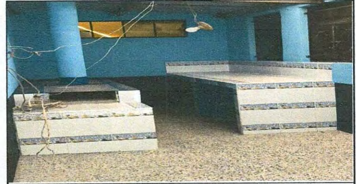
Foto 12: Sustitución de plancha, azulejo y mejoramiento de mesa de concreto
