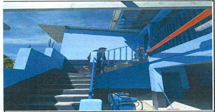
Foto 6: Canales y bajadas de agua pluvial
