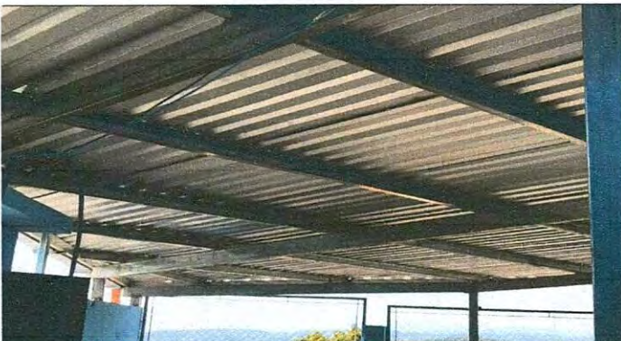
Foto 3: Cambio de lámina y estructura de techo
