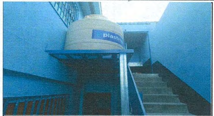
Foto 14: Mejoramiento de base para tinaco
