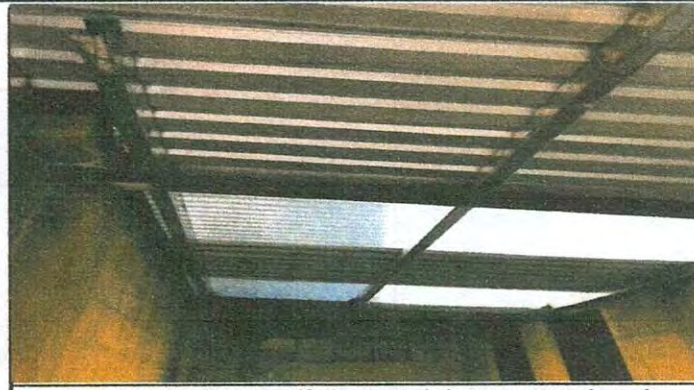
Foto 2: Cambio de Lámina por lámina troquelada y estructura de madera por metal
