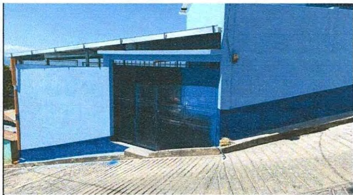
Foto 9: Mantenimiento a portones
