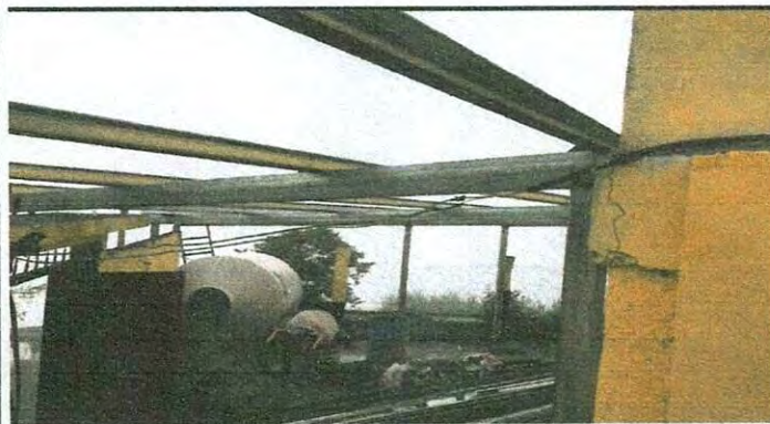
Foto 3: Cambio de lámina y estructura de techo
