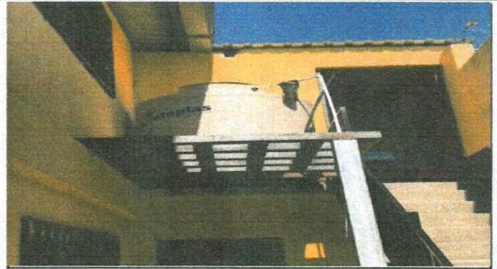
Foto 14: Mejoramiento de base para tinaco
