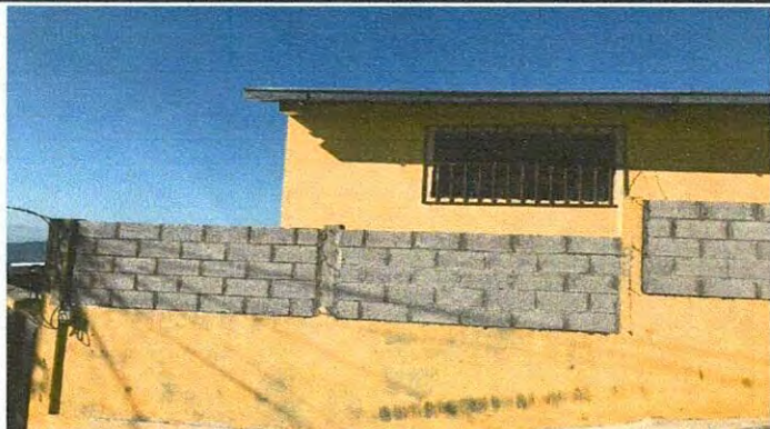
Foto 7: Reparación de muro perimetral
