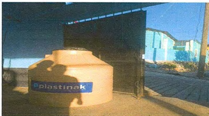
Foto 10: Reparación y mantenimiento de cisternas / Depósitos de agua
