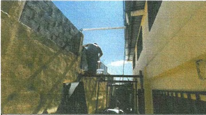
Foto 13: Reparación de repello y cernido de paredes (cuando aplique)
