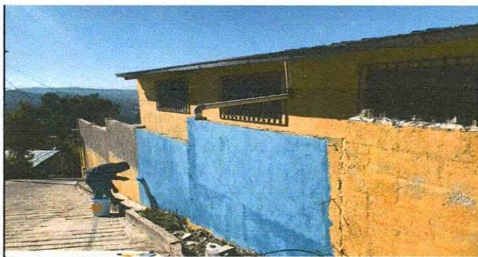
Foto 11: Pintura en interiores y exteriores
