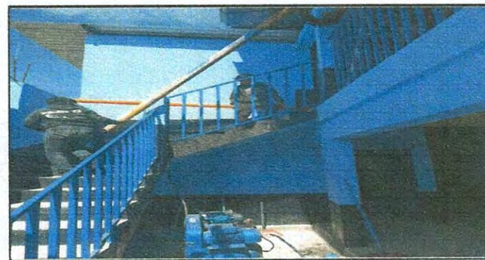
Foto 6: Canales y bajadas de agua pluvial
