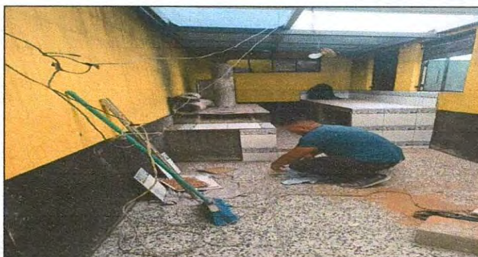
Foto 12: Sustitución de plancha, azulejo y mejoramiento de mesa de concreto
