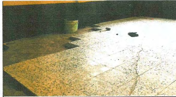
Foto 4: Sustitución de piso por piso de granito
