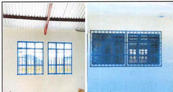
FOTO 3: Mejoramiento a estructura de metal de ventana
