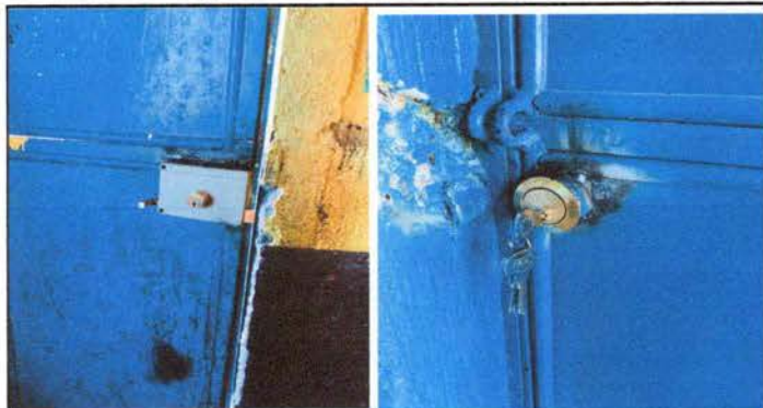
FOTO 1: Sustitución de chapas
