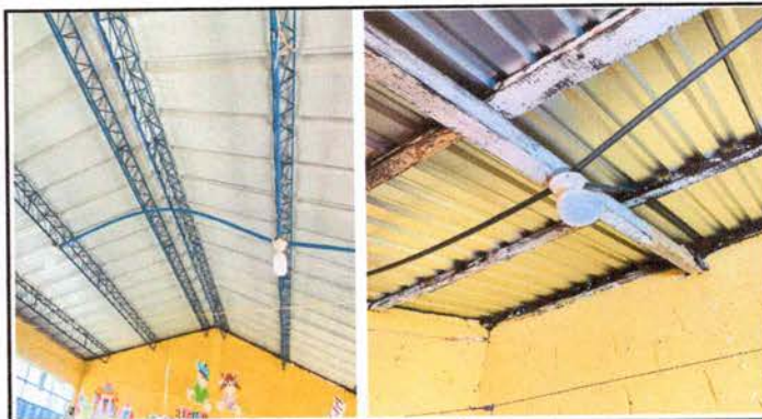
FOTO 10: Sustitución de focos ahorradores
