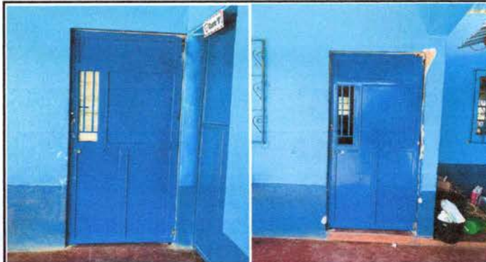
FOTO 2: Sustitución de Puerta de madera por metal
