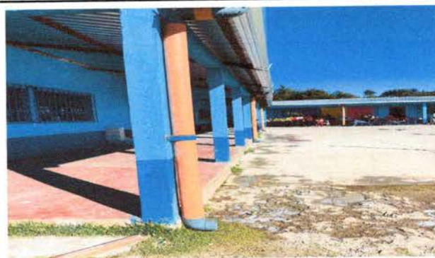
FOTO 8: Sustitución de bajada de agua pluvial de metal por tubo pvc de 3"
