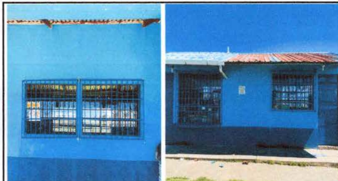
FOTO 4: Mejoramiento a balcones de metal
