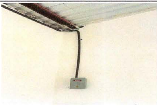
Foto 15: Sustrucción de Tablero de Flipones
