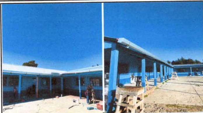
FOTO 7: Sustitución de Canal de Metal
