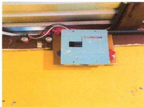
Foto 14: Sustrucción de Flipones
