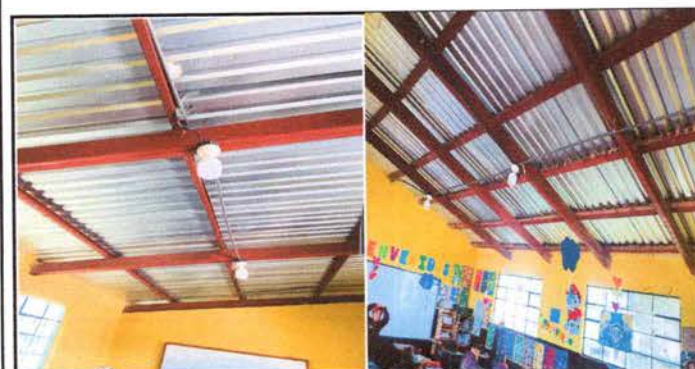
FOTO 11: Sustitución de Plafoneras
