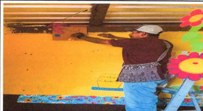
Foto 14: Sustitución de Flipones
