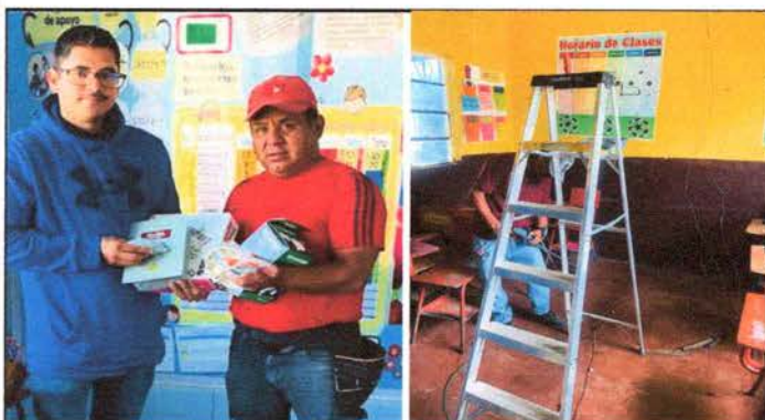
Foto 15: Sustitución de Tablero de Flipones
