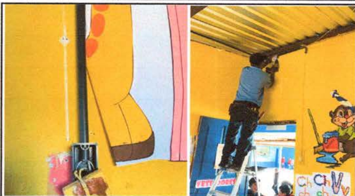
Foto 13: Sustitución de Tomacorrientes Dobles
