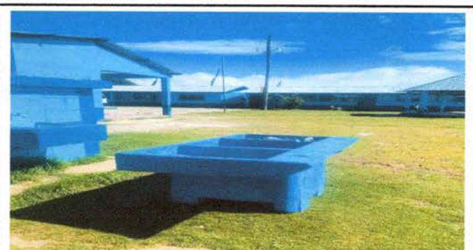
FOTO 18: Sustitución de pila de cemento de 2 lavaderos
