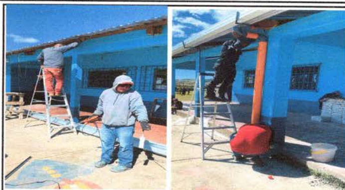
FOTO 8: Sustitución de bajada de agua pluvial de metal por tubo pvc de 3"
