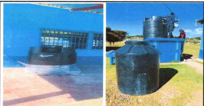
FOTO 17: Sustitución de deposito de agua 1,700 lt
