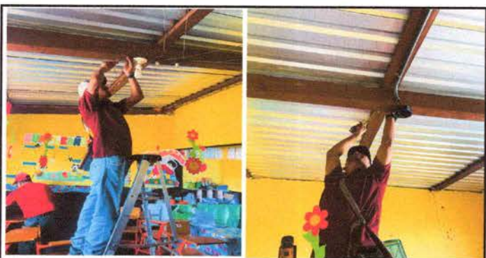
FOTO 11: Sustitución de Plafoneras
