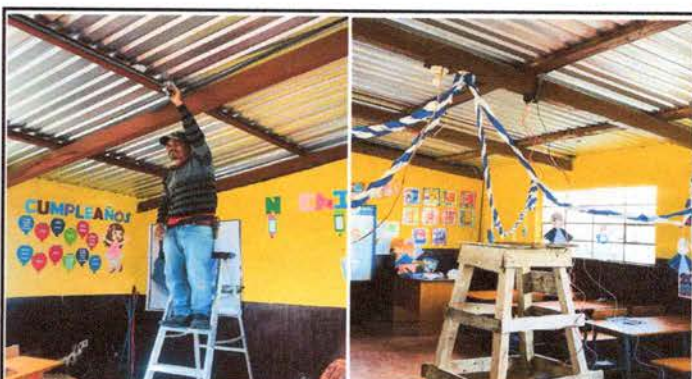
FOTO 10: Sustitución de focos ahorradores
