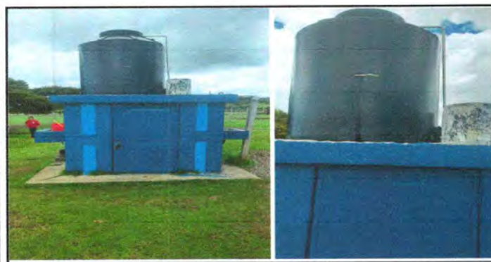
FOTO 17: Sustitución de deposito de agua 1,700 lt
