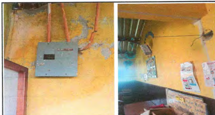
Foto 15: Sustitución de Tablero de Flípones
