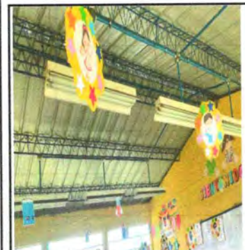
FOTO 11: Sustrucción de Plafoneras
