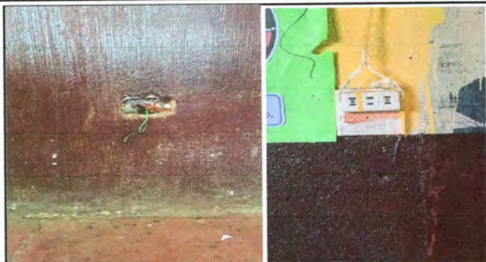
Foto 13: Sustitución de Tomacorrientes Dobles
