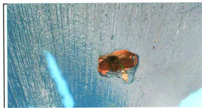
FOTO 12: Sustrucción de Interruptores Simples
