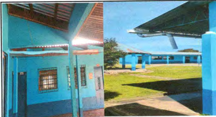
FOTO 8: Sustrucción de bajada de agua pluvial de metal por tubo pvc de 3"
