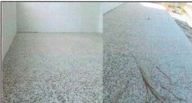
Foto 4: Mejoramiento de piso granito en aula
