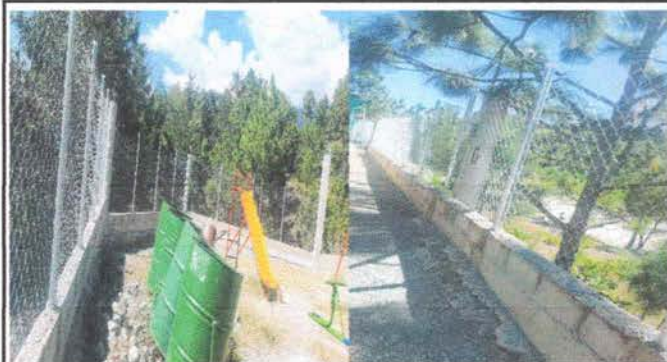
Foto1: Sustrucción de muro perimetral de block y malla por muro perimetral de block con tubo hg y malla galvanizada, soleras intermedias y columnas
