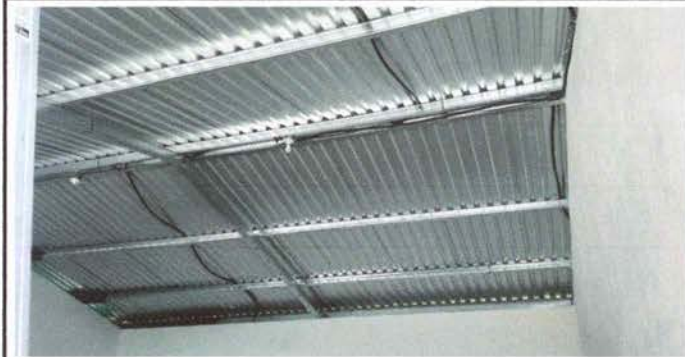
Foto 7: Mejoramiento de estructura de soporte de metal
