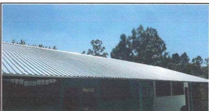
Foto 6: Mejoramiento de lámina troquelada aluzinc calibre 26
