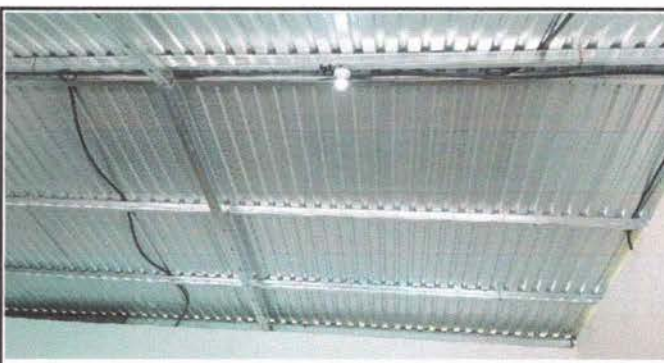
Foto 6: Mejoramiento de lámina troquelada aluzinc calibre 26
