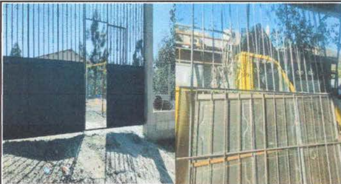
Foto 3: Sustrucción de porton de metal de 5mts de ancho por 2.8 mts de alto
