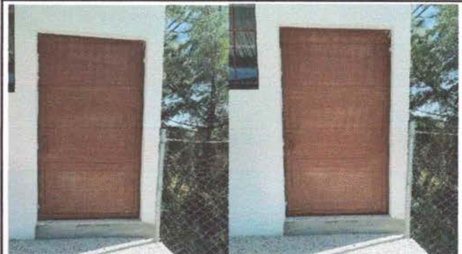
Foto 2: Sustrucción de puerta de metal de aula
