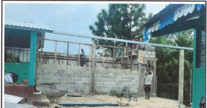
Foto 8: Mejoramiento de pared y soporte de mojinete del techo
