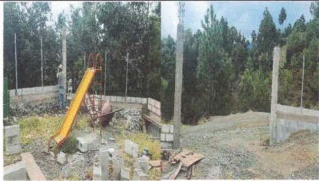
Foto1: Sustrucción de muro perimetral de block y malla por muro perimetral de block con tubo hg y malla galvanizada, soleras intermedias y columnas
