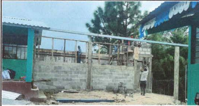
Foto 7: Mejoramiento de estructura de soporte de metal
