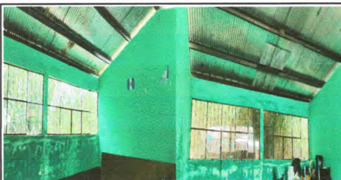
Foto 5: Sustrucción de lámina, por lámina troquelada aluzinc calibre 26
