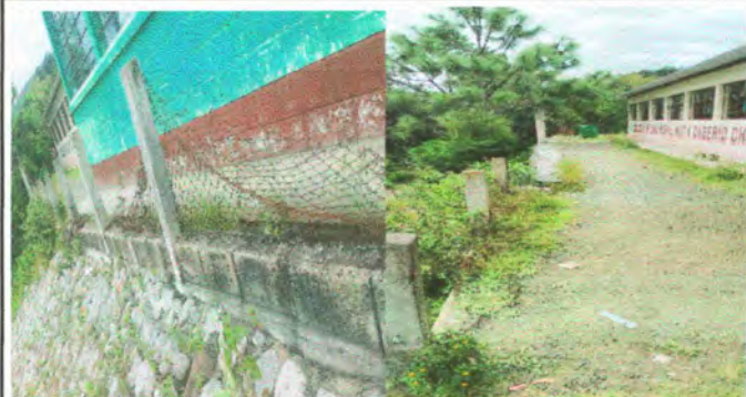
Foto 1: Sustrucción de muro perimetral de block y malla por muro perimetral de block con tubo hg y malla galvanizada, soleras intermedias y columnas
