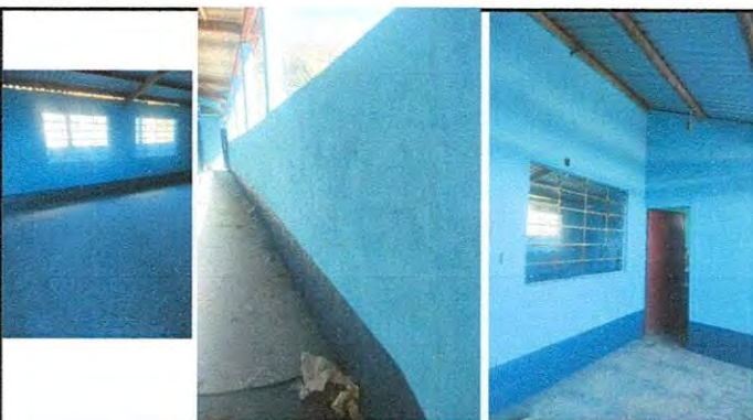
Foto 4: Pintura en muros exteriores e interiores.
