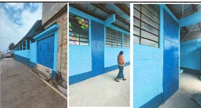
Foto 5: Mantenimiento a estructura, aplicación de pintura a puertas de servicios sanitarios, puertas de aulas, cocina y portón principal.
