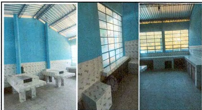
Foto 10: Reparación de cocina. Sustitución de estufa rural. Incluye chimenea y plancha de metal. Instalación de azulejo en muebles de cocina.
