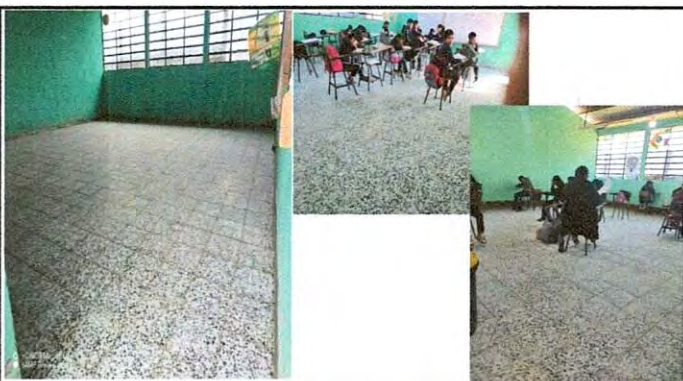
Foto 3: Sustitución de torta de concreto en 3 aulas.
