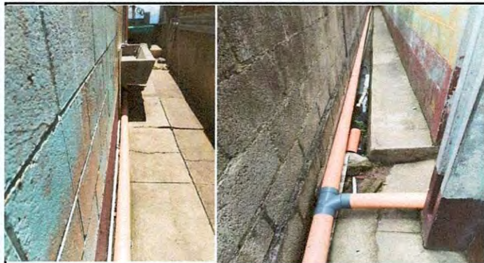
Foto 7: Reparación de red de drenaje. Sustitución de tubería PVC línea principal de aguas pluviales.
