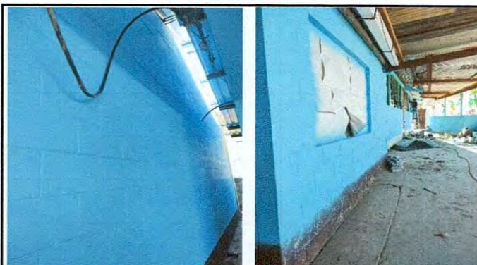
Foto 4: Pintura en muros exteriores e interiores.
