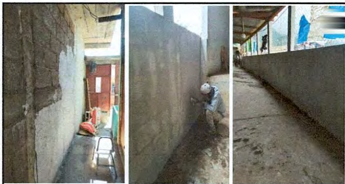
Foto 11: Reparación de cernido y repello de paredes. Repello de muro interno y externo.
