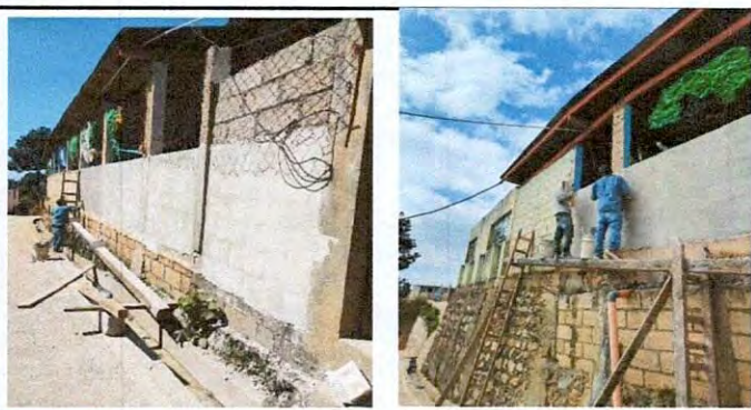
Foto 12: Reparación de muro de contención. Aplicación de sabieta en muro de contención.
