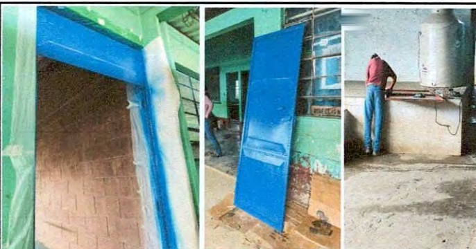
Foto 5: Mantenimiento a estructura, aplicación de pintura a puertas de servicios sanitarios, puertas de aulas, cocina y portón principal.
