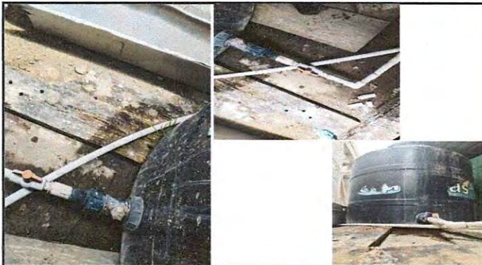
Foto 9: Reparación y mantenimiento de cisternas/depósitos de agua. Sustitución de accesorios de depósito de agua sustitución de depósitos de agua 1,100 litros.
