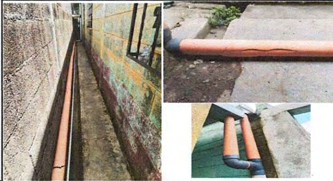
Foto 7: Reparación Red de Drenaje: Sustitución de tuberías PVC línea principal aguas pluviales. red de agua potable.
