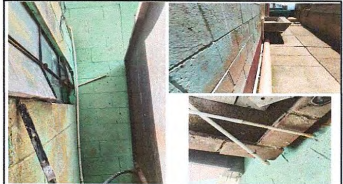
Foto 8: Red de agua potable, sustitución de línea principal, sustitución llaves de chorro.
