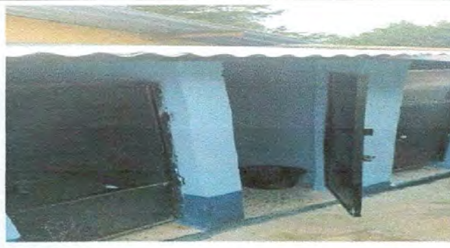
FOTO 2: Mantenimiento a estructura de puertas de baños ( lijado, cepillado, aplicación de pintura y ampliación de 0.40 mts de alto)
