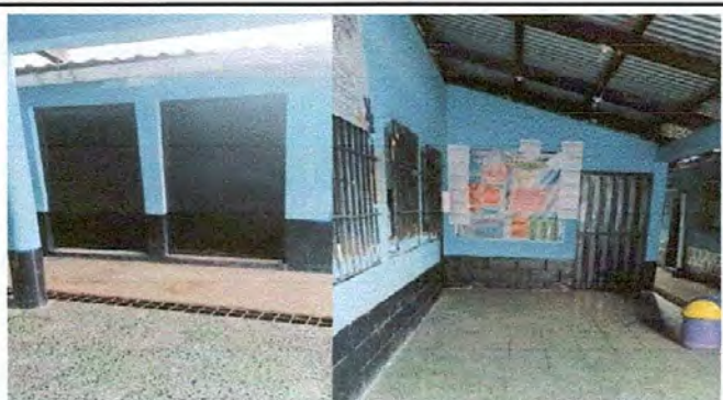
FOTO 3: Mantenimiento a estructura de puertas de aulas ( lijado, cepillado, aplicación de pintura)
