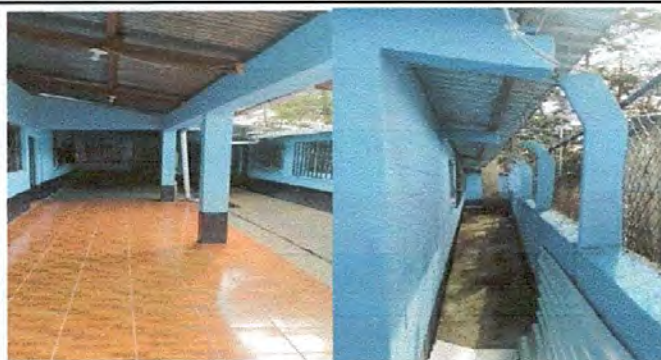
FOTO 9: Pintura de muros exteriores e interiores
