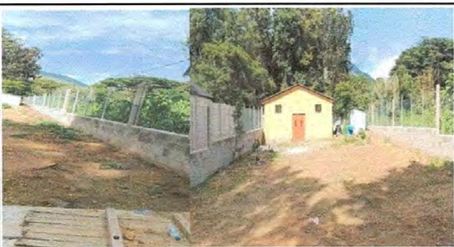
FOTO 11: Sustitución de muro perimetral madera y malla por clock con tubo hg y malla galvanizada, solera y columnas
