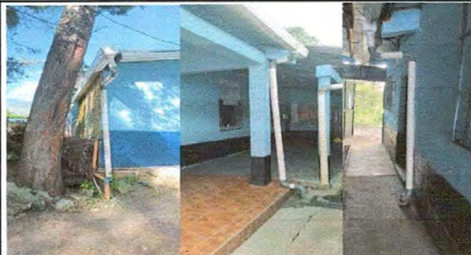
FOTO 8: Sustitución de bajada de agua pluvial por tubo PVC 4"
