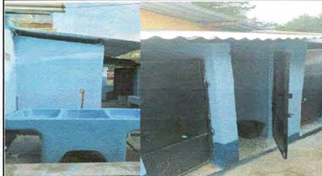
FOTO 14: Sellado de grietas y fisuras de muros (sabieta) de cocina y baños
