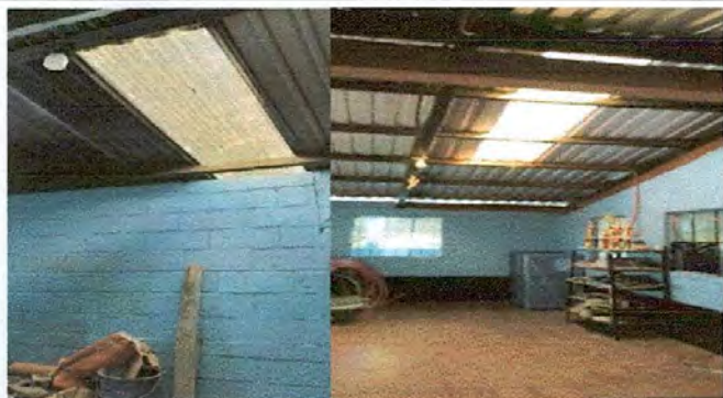
FOTO 1: Sustitución de lamina por lamina troquelada calibre 26 y tragaluz
