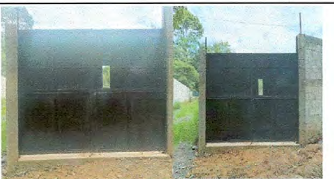
FOTO 5: Sustitución de porton 2.50 mts de alto por 4 mts de ancho dos hojas
