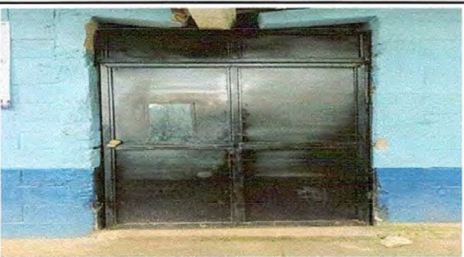
FOTO 4: Sustitución de porton 2.40mts de alto por 1.34 mts de ancho
